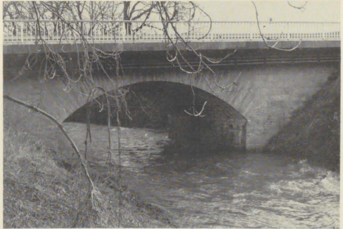
Abb. 4: Brücke im Zuge der B34 bei Tiengen/Oberrhein über die Steina.
