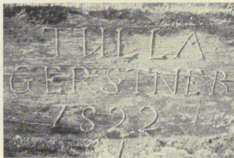
Abb. 6 a: Brücke in Weingarten/Baden, Signatur im Gewölbebogen.
