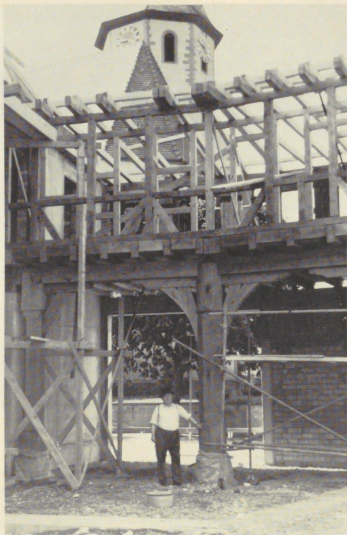
Baustelle neues Rathaus (1973) auf dem ehem. Hauffe-Grundstück
