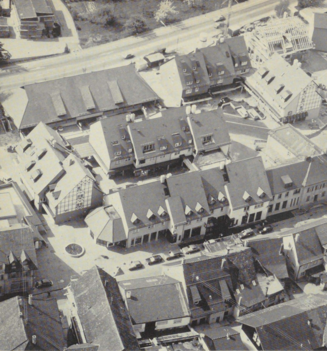
Gesamtansicht des Wohn- und Geschäftszentrums „Ochsenplatz“ mit Parkhaus
