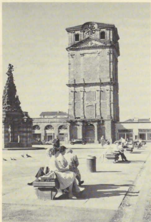
Die Turmruine mit den provisorisch bergerichteten Kaufhausläden in den 50er Jahren
