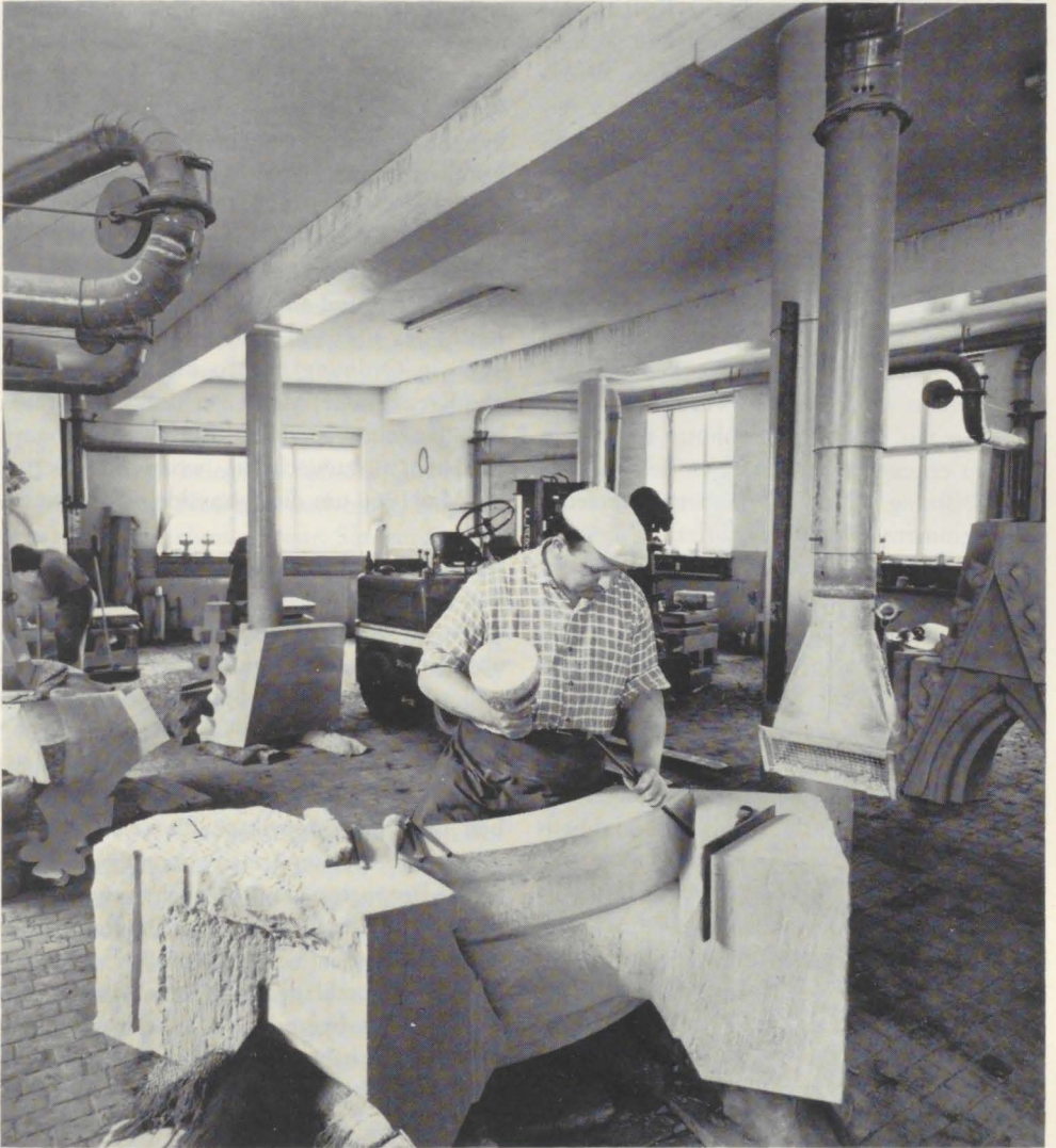
Abb. 5: Blick in die heutige Werkstatt: Im Vordergrund ist ein Stück eines Maßwerkes für die Pyramide des Hauptturmes in Arbeit. Die an einigen Stellen sichtbaren Blechrohre sind Bestandteile der Absauganlage
