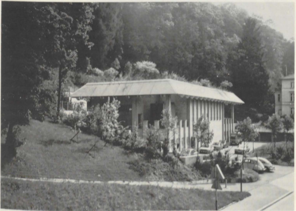
Das 110 kV-Umspannwerk am Schloßbergring. Für die architektonische Gestaltung erhielt das Bauwerk bei einem Bundeswettbewerb eine Goldplakette
