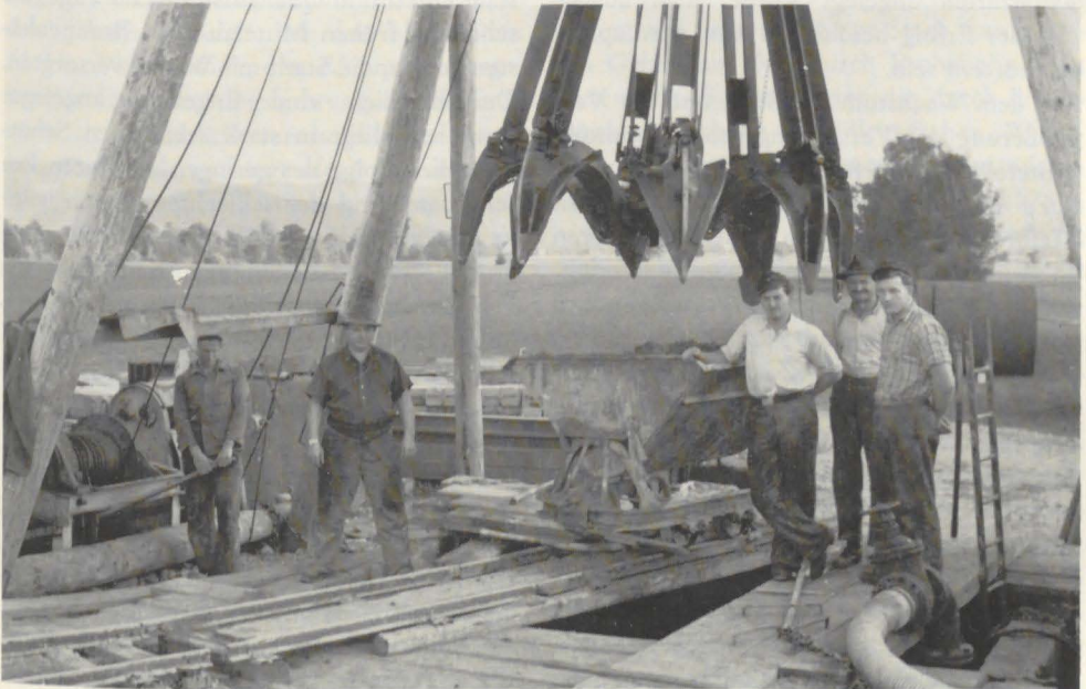
Bau des Tiefbrunnens Krümmatten 5 im Dreisamtal (Oktober 1956) als Greiferbohrung. Der Greifer ist gerade geöffnet und einfahrbereit
