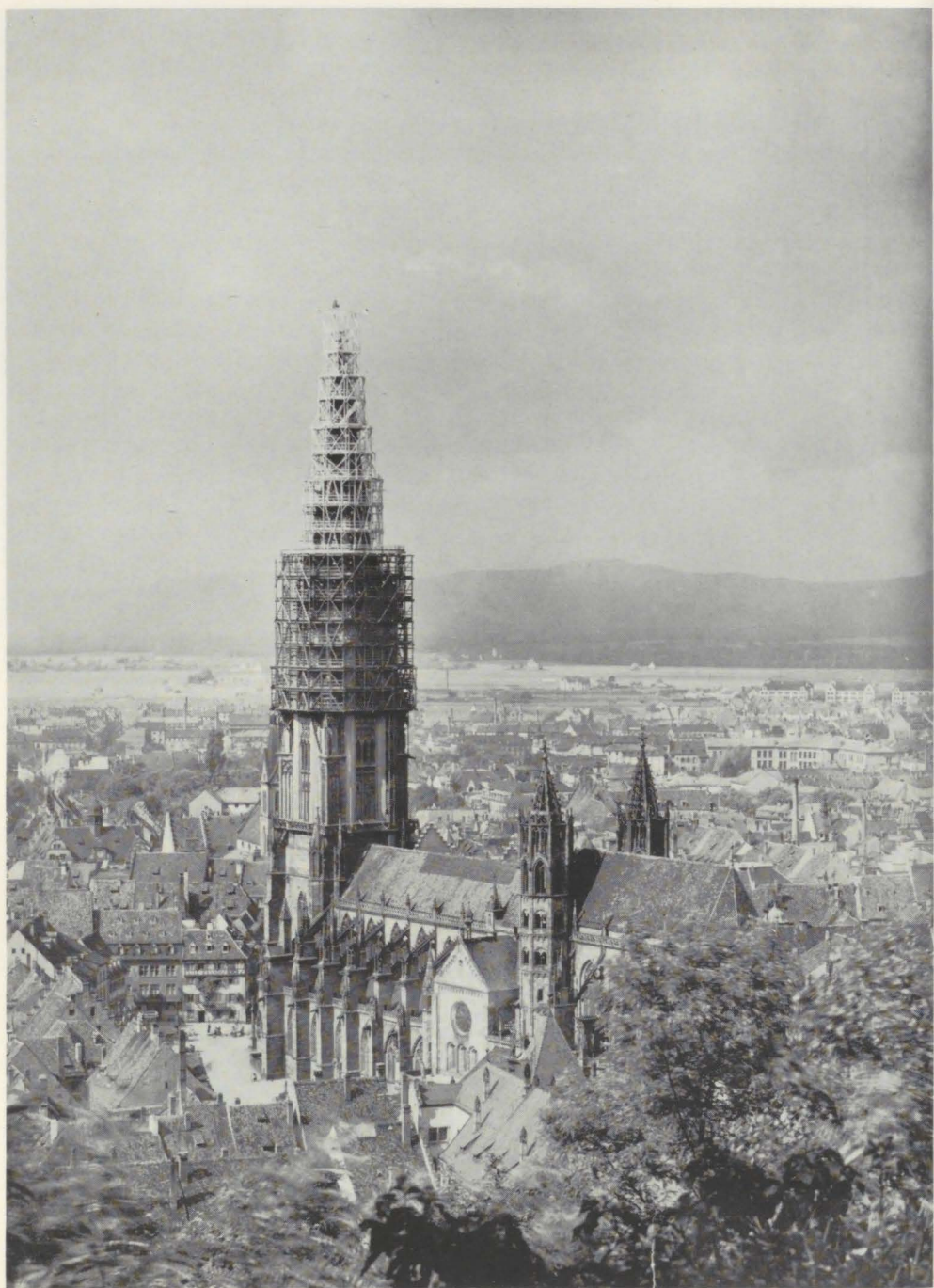
Abb. 3: Das Holzgerüst am Münsterturm im Jahr 1919. 300 m 3 Holz waren für das Gerüst notwendig
