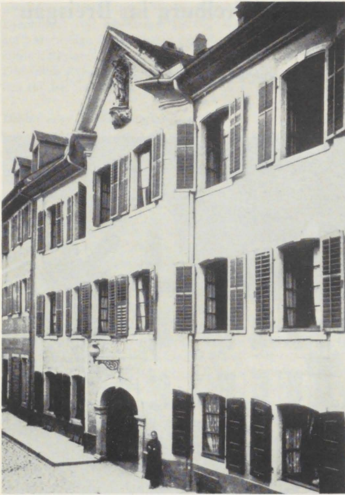
Das Haus „Zur lieben Hand“ in Freiburg i.Br., Löwen- straße 16, ehem. „Ebringer Hof“
