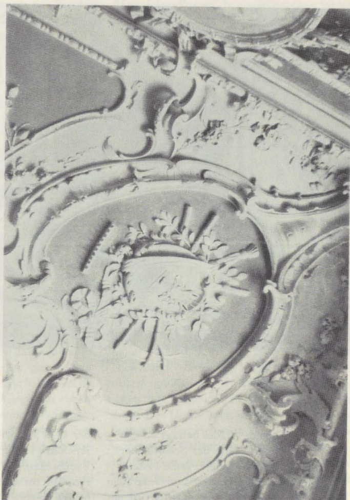
Kislau Schloß, Bad, Herbst/Wasser, Zustand n. d. Rest.
