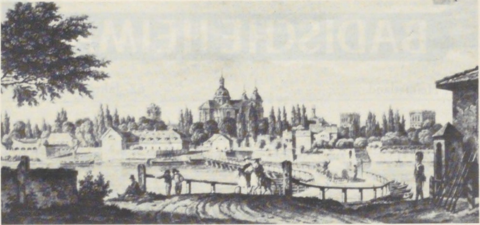
Freihafen am Rhein in Mannheim 1828 (links auf dem Mannheimer Ufer die Verlade- und Lagereinrichtungen dieser ältesten Schiffsanlegestelle am Rhein)
