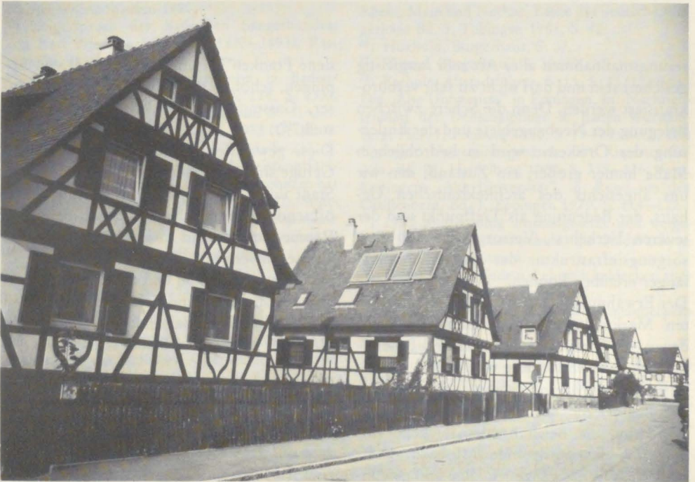
Wiederaufgebautes Öschelbronn bei Pforzheim
