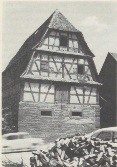
Gemmingen, Zehntscheuer vor Umbau
