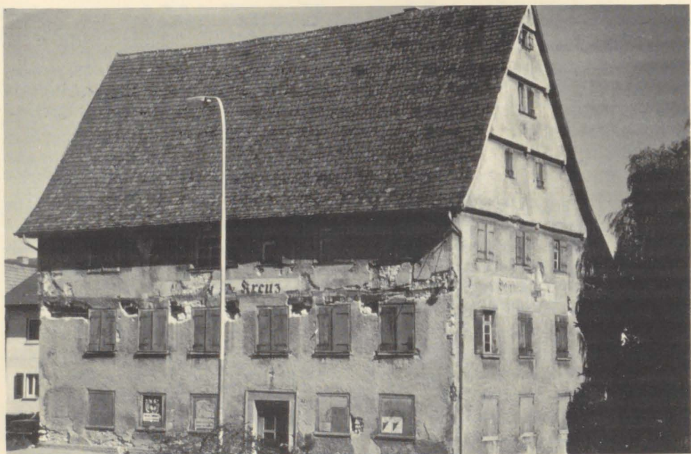
Fachwerkhaus „Kreuz“ in Stetten a. k. M. Zustand im Herbst 1979
