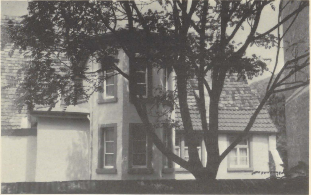
Rückseite des „Mönchhofes“ nach der Renovierung. Das Haus wurde zur Augenweide der Bewohner des Stadtteils
