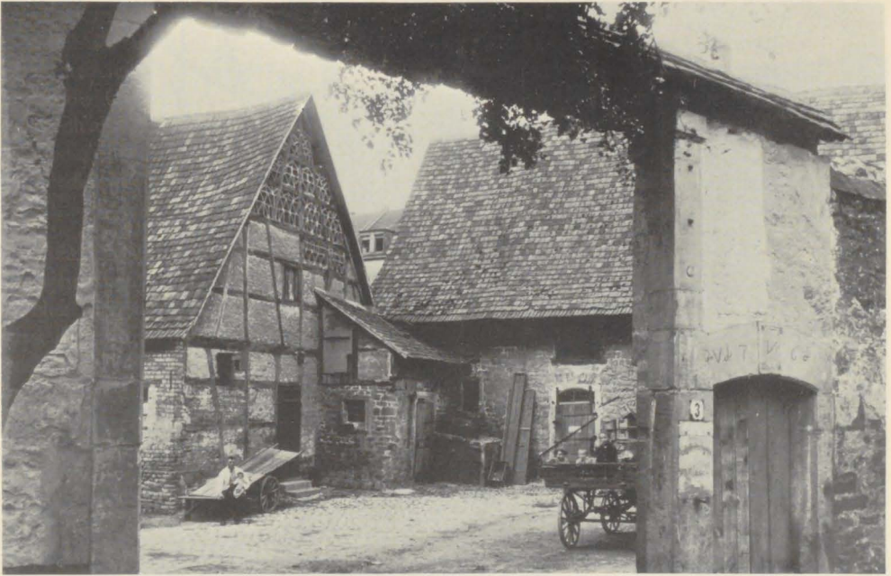
Blick durch die Toreinfahrt des ehemals Gerlach'schen Hauses auf die Scheune, deren Giebelseite einfaches Fachwerk und Netzmauerwerk aufweist
