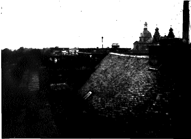
Dach des Pavillons an der Schloßkirche als Beispiel der jetzigen versenkten Dachkonstruktion.
