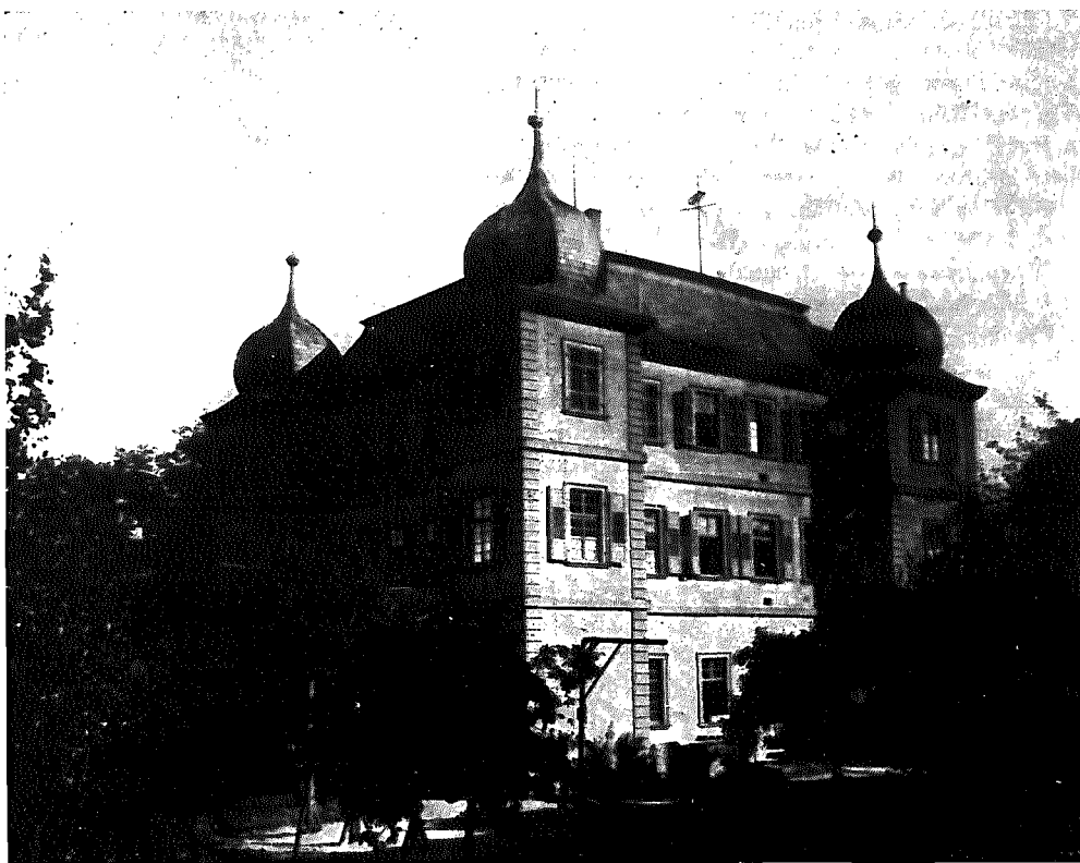
Abb. 2: Ivesheim, Schloß. Außenansicht von Norden.
