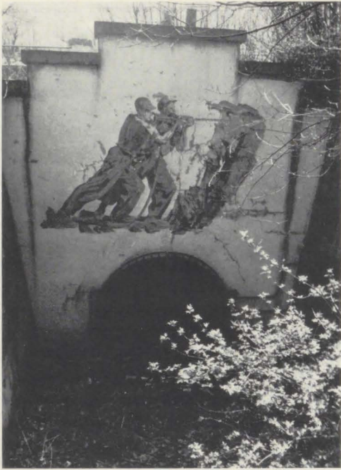
5) Das Stollenmundloch des Eisenbahnstollens am Zechenweg. 1976.
