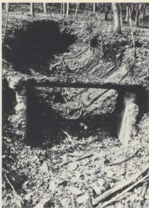
3) Vom Stollen 4 blieb nur noch der Rest vom Stollenzugang. Dahinter ist der Stollen zerbrochen. 1976.
