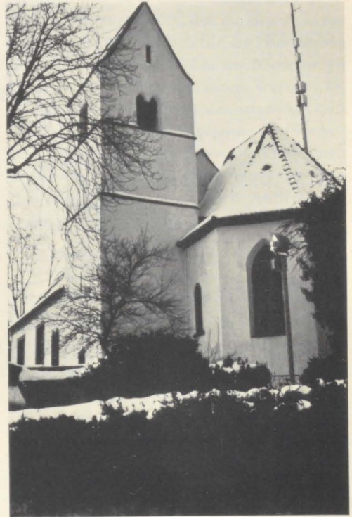
14) Die Kirche nach der Renovierung
