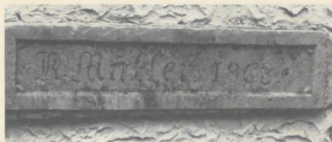
12) Als Weinbergstein benützter Türsturz von 1863, früher im Gewann „Haubenstein“, jetzt eingemauert in Haus Harnischgasse 15. Mosbach.
