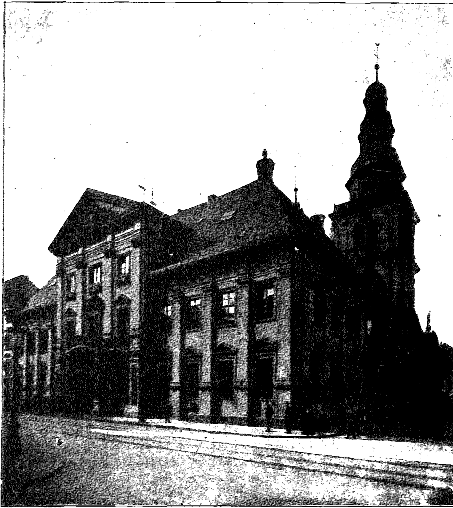
Das Rathaus in Mannheim. Nach einer photogr. Aufnahme Ecke Breitestraße-Marktplatz.
