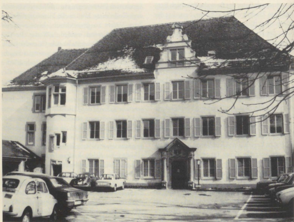
Gebäude des Landratsamts Waldsbut im März 1975
