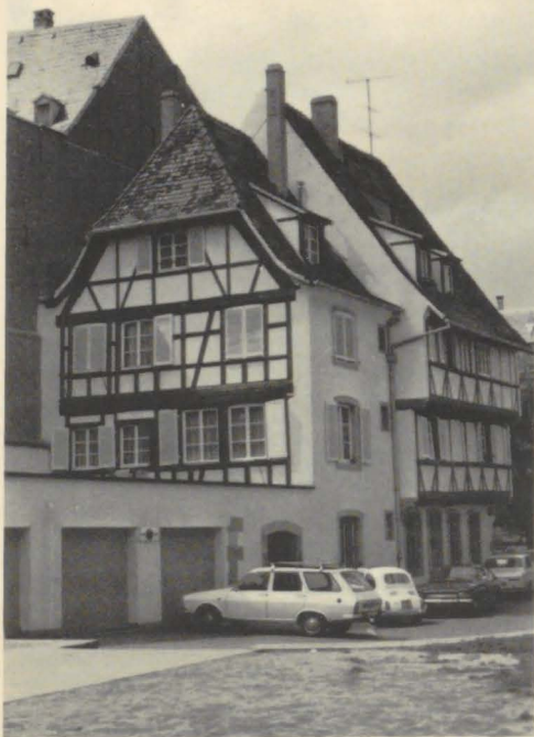
Straßburg. Dieses typisch straßburgische Fachwerkhaus des Spätmittelalters hat durch eine muster-gültige Renovation wieder seinen alten Glanz erhalten, der seiner architektonischen Qualität und wichtigen städtebaulichen Stellung würdig ist.
