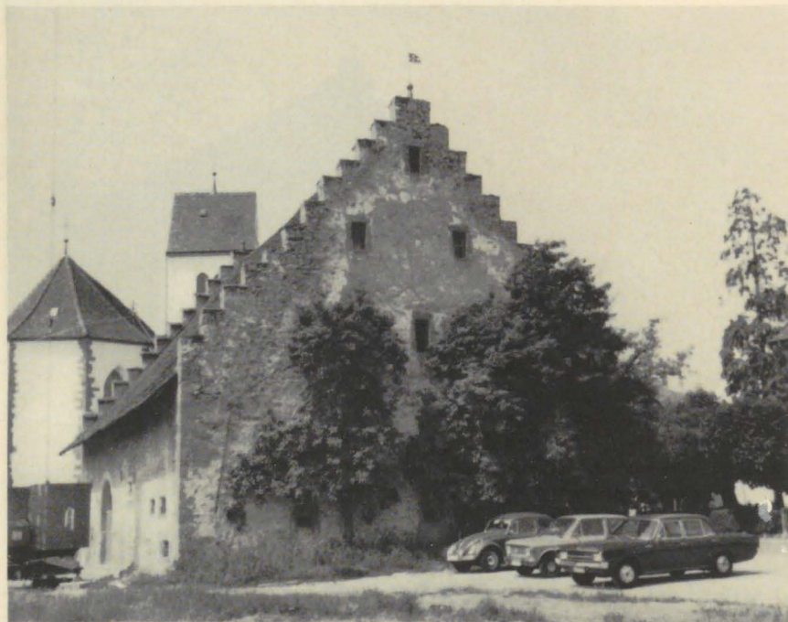
Zehntscheuer in Rheinheim, Nordostansicht
