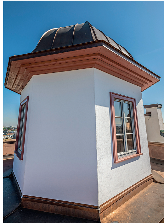
Das neue Türmchen auf der Plattform (Foto: Thomas Henne, Mannheim 2020)
