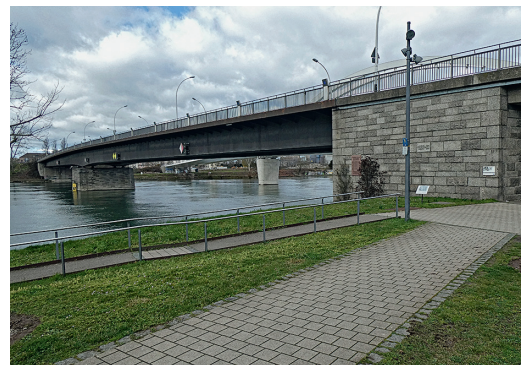
Strasbourg-Kehl, Straßenbrücke »Europabrücke«, B 28, 1960 (Ulrich Boeyng, 2020)
