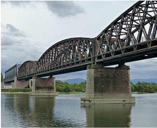
Roppenheim–Wintersdorf, Straßenbrücke mit neuer Flutbrücke, 1977 (Ulrich Boeyng, 2020)
