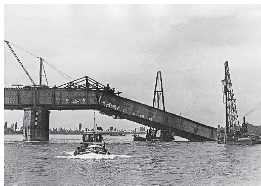
Frankenthal–Mannheim, Reichsautobahnbrücke RAB 38, Einsturz Dezember 1940 (BAW, HB08922)
