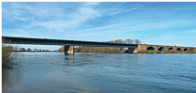
Frankenthal-Mannheim, Autobahnbrücke A 6, 1950 (Ulrich Boeyng, 2020)
