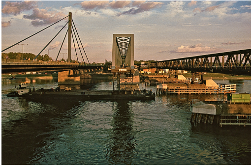
Maximiliansau-Maxau, Neubau Eisenbahnbrücke I, 1991 (links B 10, rechts SKR) (Ulrich Boeyng, 1987)
