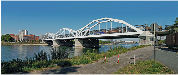
Ludwigshafen–Mannheim, S-Bahn- und Eisenbahnbrücke, 1999 (Ulrich Boeyng, 2020)
