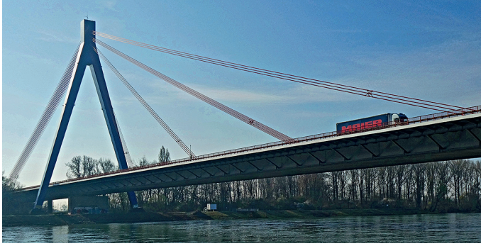
Speyer, Autobahnbrücke A 61, 1974 (Ulrich Boeyng, 2020)
