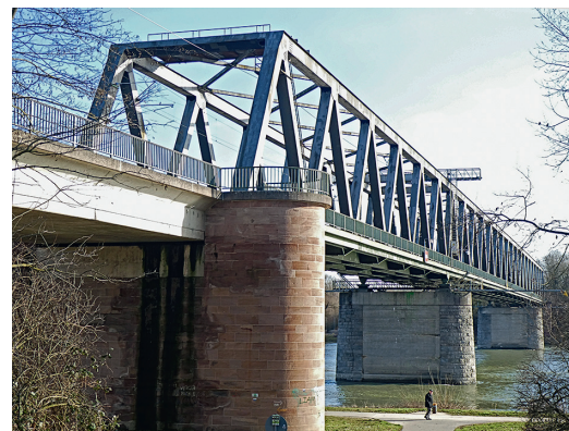
Germersheim, Eisenbahn-Brücke, 1967 (Ulrich Boeyng, 2020)
