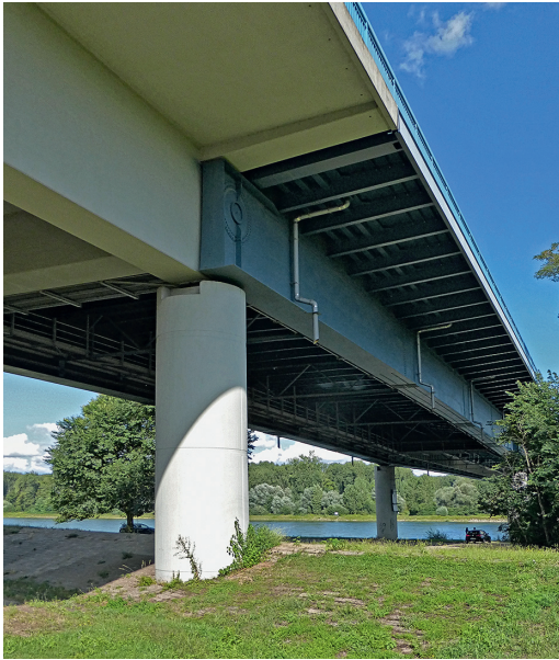
Germersheim, Straßenbrücke, B 39, 1971 (Ulrich Boeyng, 2020)
