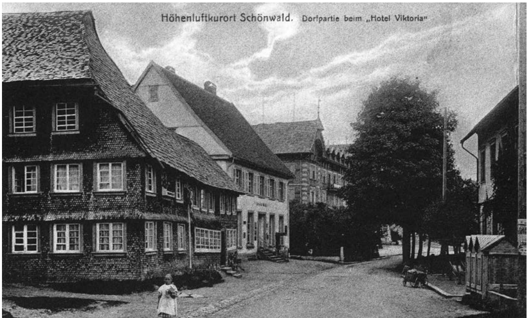
Bild 6: Dieses um 1920 entstandene Foto zeigt u. a. drei Gebäude sehr unterschiedlicher Architektur und Bauzeit in Schönwalds Dorfkern. In dem Brunnenhäuschen gegenüber dem historischen Schwarzwaldhaus (vor 1740 erbautes Doppelhaus, abgebrochen 1978/79) hatten – ähnlich Bild 2 – etliche Familien ihre „Milchhäusle“, und auch das Wasser holten sie in Eimern, Kübeln oder Kannen von diesem Brunnen. Deutlich erkennbar ist der harte Kontrast zwischen dem dörflichen Wohnen und Leben und dem angestrebten noblen Kurbetrieb.
