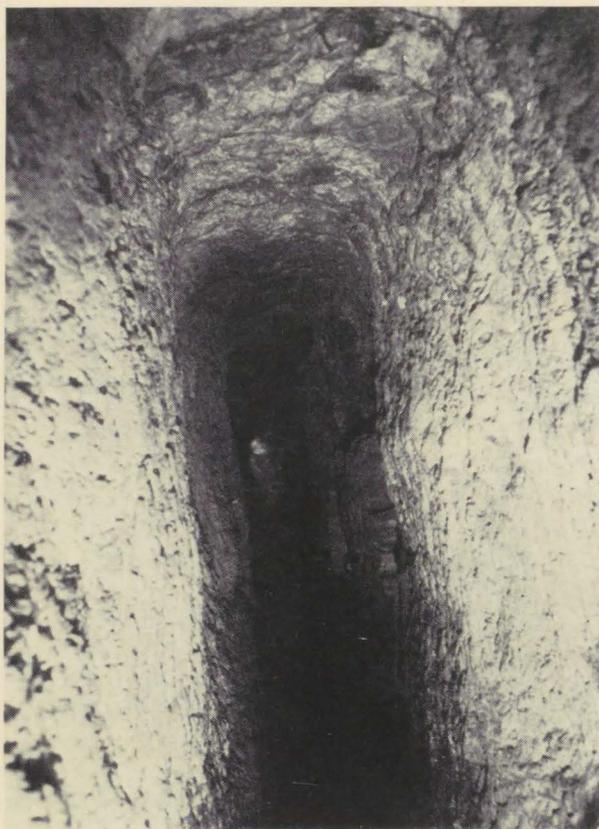
*Ein Stollenvortrieb in der Grube Riggensbach mit deutlichen Schlagspuren von der Schlägel- und Eisenarbeit mit Blickrichtung nach außen. Die Profilhöhe spricht etwa für 16. Jahrhundert.*
