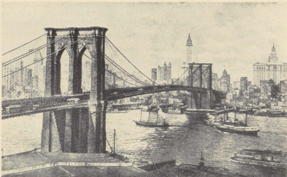
Die Brooklyn-Brücke von New York, USA. Aus „Einführung in die moderne Kunst“ von Fritz Burger. 1916
