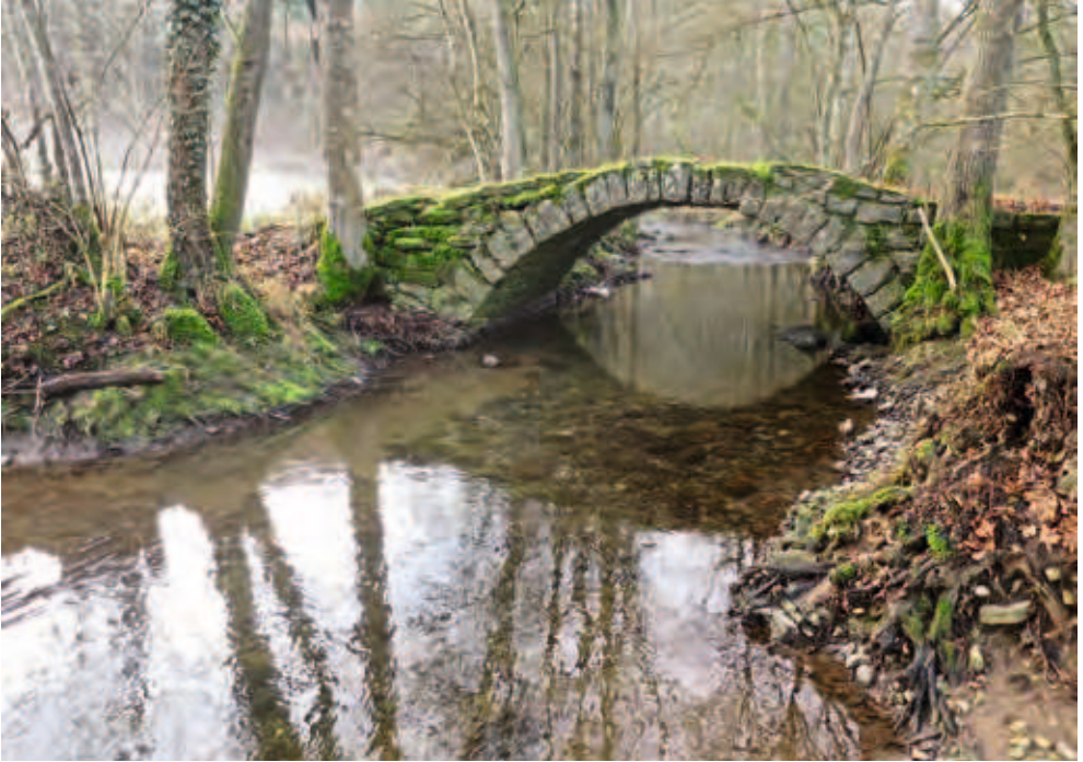
Eine der fünf idyllischen Bogenbrücken am Buchenbach bei Affalterbach-Wolfsölden.
