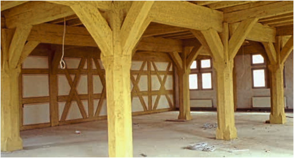
Die ehemalige »Danzstatt« bei der Restaurierung von 1984/86.
