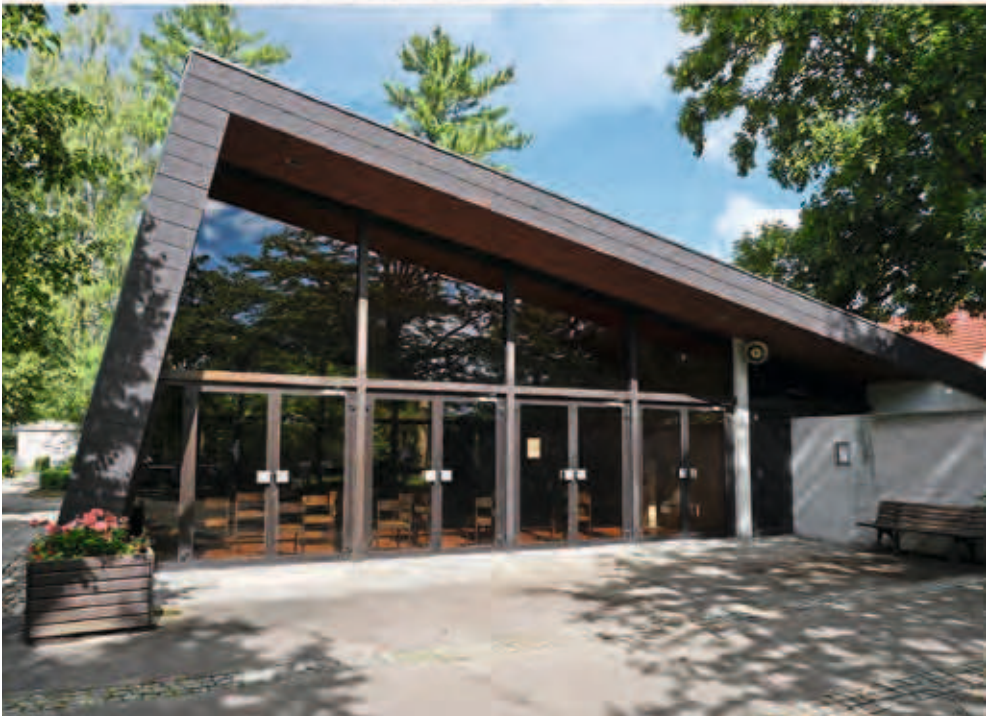
Altes Leichenhaus (oben) und neue Aussegnungshalle auf dem Heimerdinger Friedhof.
