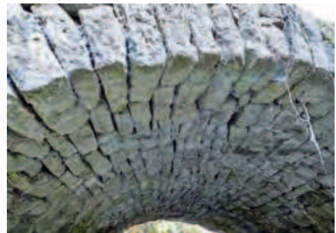
Gewölbe der Bogenbrücke am Gründelbach bei Freiberg-Heutingsheim; deutlich sieht man die Verzahnung der Steinblöcke.
