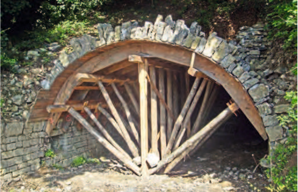
Beispiel eines Lehrgerüsts – hier an einem Kellereingang.
