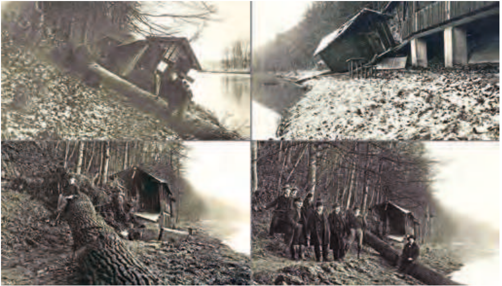
Zerstörter Badeplatz des Schwimmvereins. Obere Reihe: Schaden durch eine umgestürzte Pappel, November 1919; untere Reihe: Hochwasserschaden, Dezember 1919. (Schwimmverein Ludwigsburg)
