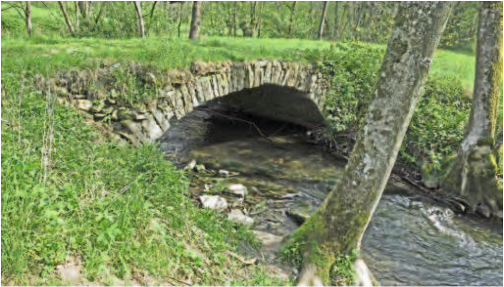
Brücke am Buchenbach bei Affalterbach-Steinächle.
