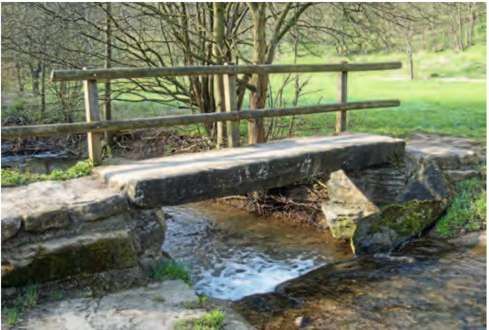
Der Sandsteinblock des Steges im Baumbachtal bei Walheim ist 3,50 m lang, 1 m breit und 35 cm hoch.
