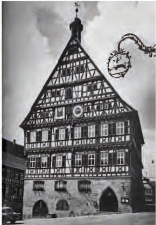
*Zwei Ansichten der Südseite des Rathauses: links mit verputzter Fassade (1826 bis 1956), rechts mit freigelegtem Fachwerk (1956 bis 1984).*
