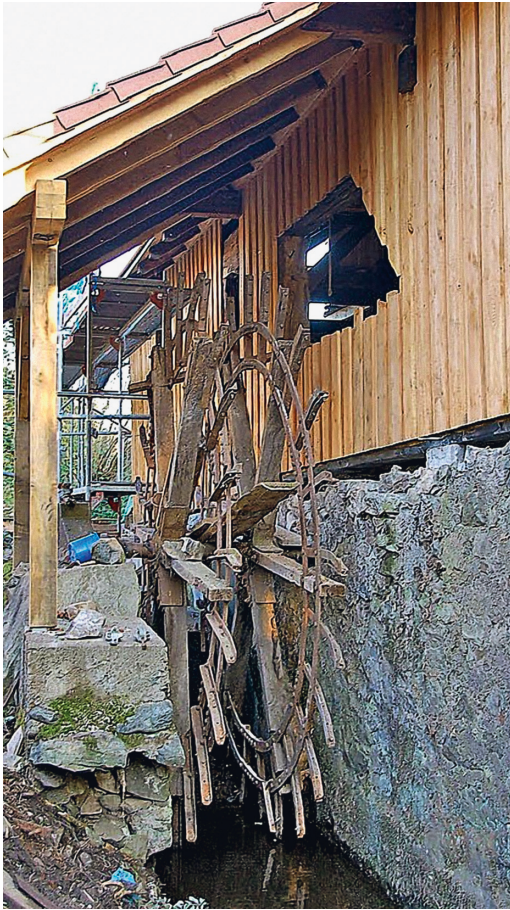
Mühlrad der »Alten Säge« vor der Renovierung ...
