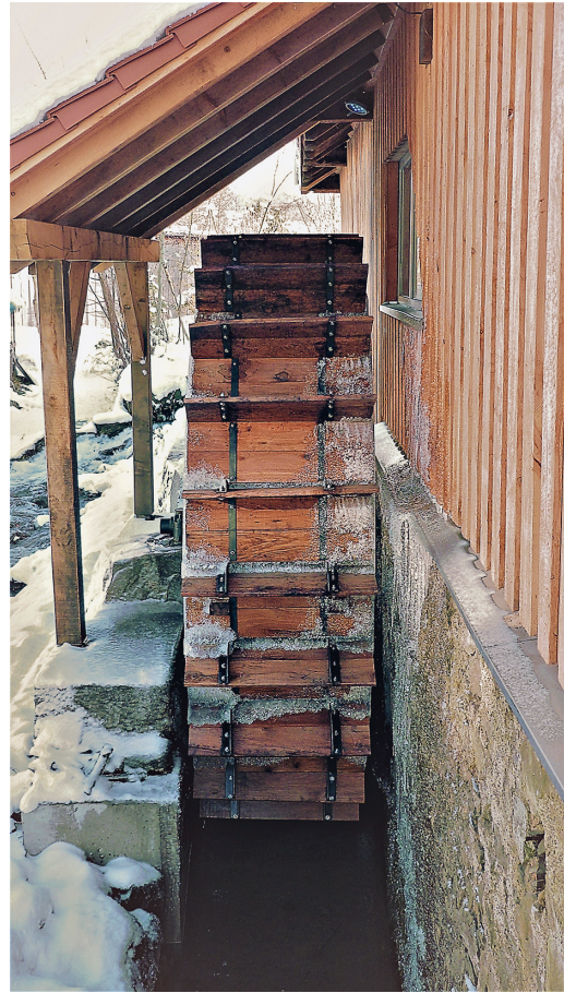
... und nach der Renovierung
