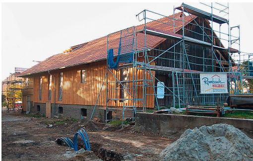
Außenansicht der »Alten Säge« während der Renovierung
