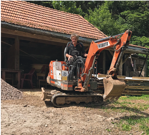
Josef Saier richtet mit seinem Minibagger das Außengelände her (Foto: Förderverein Rankmühle e. V.)
