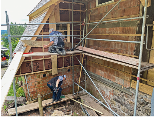
Anbringen einer neuen Holzverschalung (Foto: Förderverein Rankmühle e. V.)
