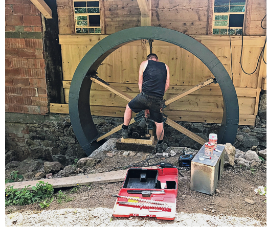
Anbringen einer neuen Holzverschalung (Foto: Förderverein Rankmühle e. V.)
