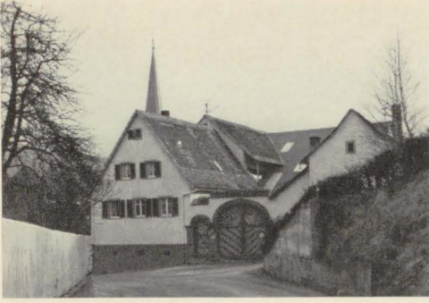
Bild 5 Altes Kaiserstühler Winzergehöft in Bickensohl mit Abschlußmauer des Hofes, die ganz von den beiden Toren eingenommen wird. Wohn- teil und Schopf stehen mit dem Giebel zur Straße. Am Wohnteil sieht man die Kellerfenster, darüber liegt über dem hohen Keller die Wohnung. Die verschiedene Art der Dachdeckung und die eingelassenen Glasfenster lassen auf manche Umbauten schließen.
