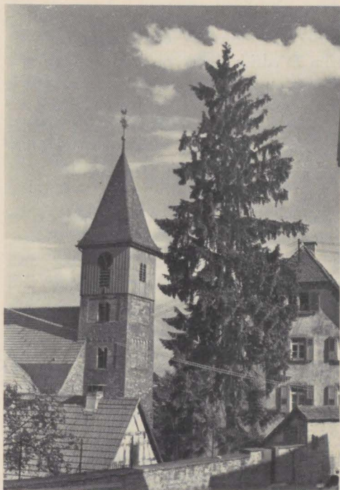
Turm von Südwesten
