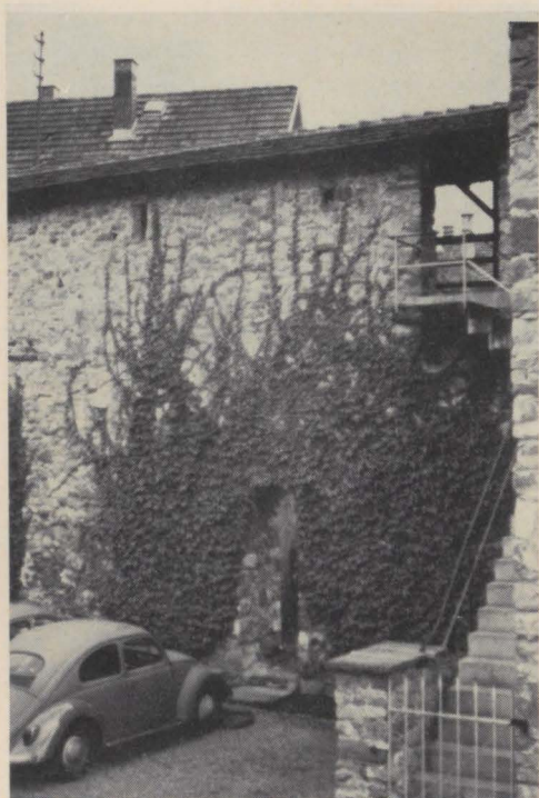
Rest der Stadtmauer, Außenseite
