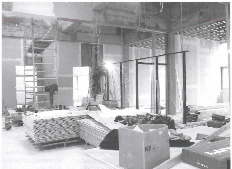
Abbildung 6. Bauarbeiten am Pavillon im Nymphengarten. In das Gebäude werden voraussichtlich in der ersten Jahreshälfte 2004 die Wissenschaftlichen Abteilungen Entomologie, Geologie und Zoologie einziehen. – Foto: SMNK (V. GRIENER).
