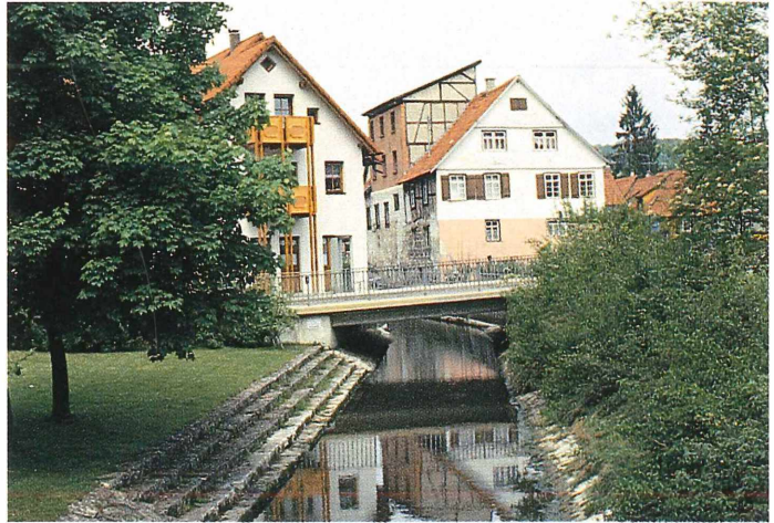
Abb. 110. Naturnah gestalteter Bachabschnitt im Siedlungsbereich wurde Lebensraum für die Wasseramsel, die einen überflutungssicheren und Beutegreifer unzugänglichen Brutplatz unter der Brücke hat.
