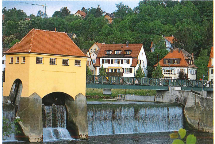
Abb. 106. Stauwehre in Gewässern können für Tiere, Tierarten oder deren Jugendformen trotz eingebauter Fischtreppe unüberwindbare Hindernisse darstellen, z. B. für Wasservogelküken.
