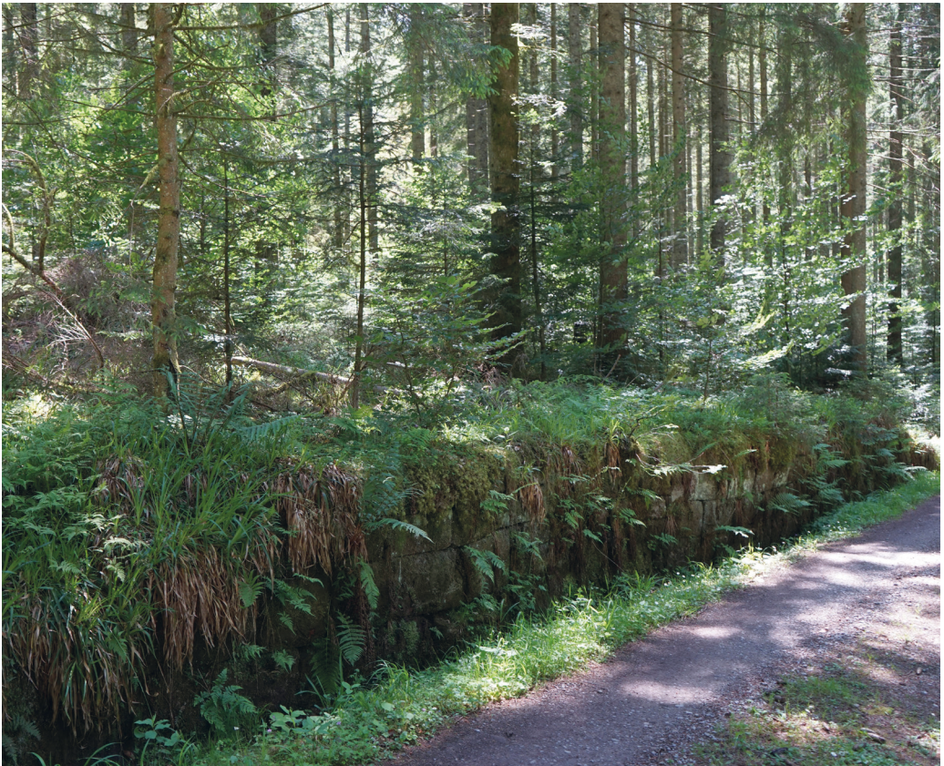
Abb. 96: Eine von mehreren Holzverladerampen oberhalb des Hüttenbächles im Einzugsgebiet der Kleinen Kinzig. Foto: Werner Konold.
