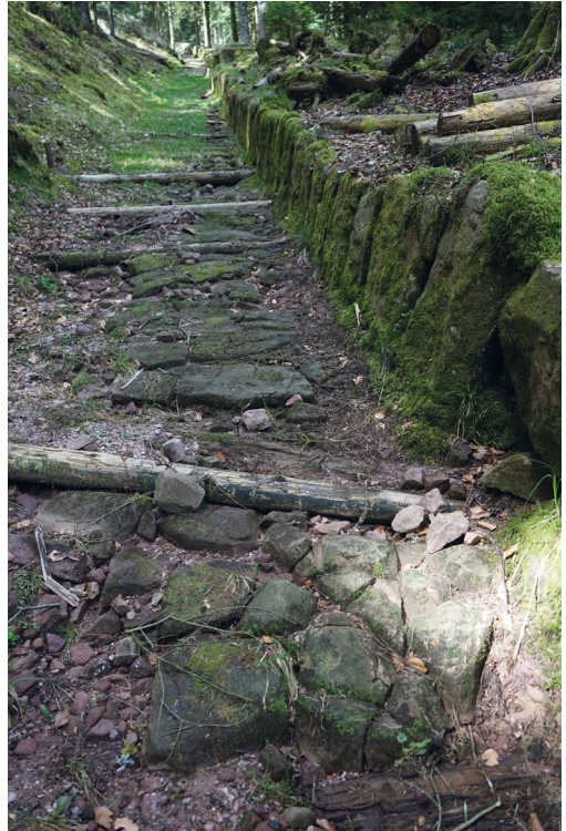
Abb. 30: Wiederhergestellte Riese in Reinerzau mit Steinpflaster, Querhölzern und einer mächtigen talseitigen Mauer. Foto: Werner Konold.
