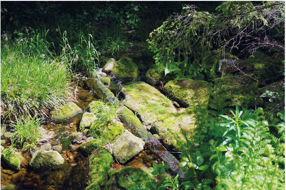
Abb. 89: Sohlschwelle und Pflasterung in der oberen Wolf. Foto: Werner Konold.
