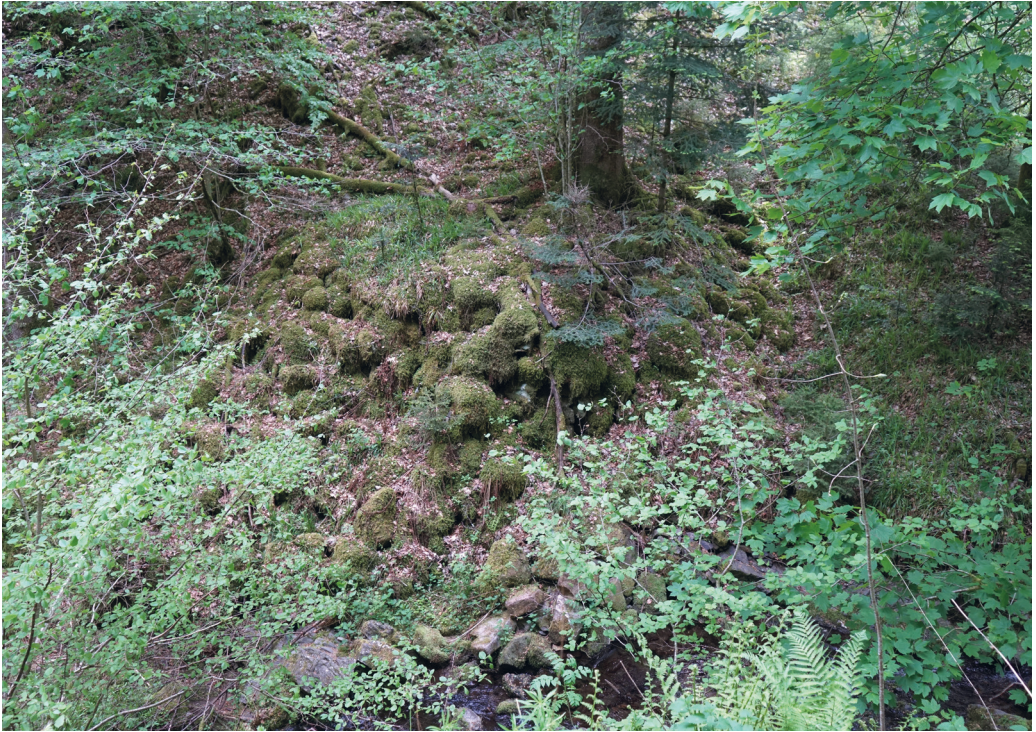
Abb. 65: Dammrest des Dollenbachweihers im hinteren Dollenbachtal (Bad Rippoldsau-Schapbach). Foto: Werner Konold.
