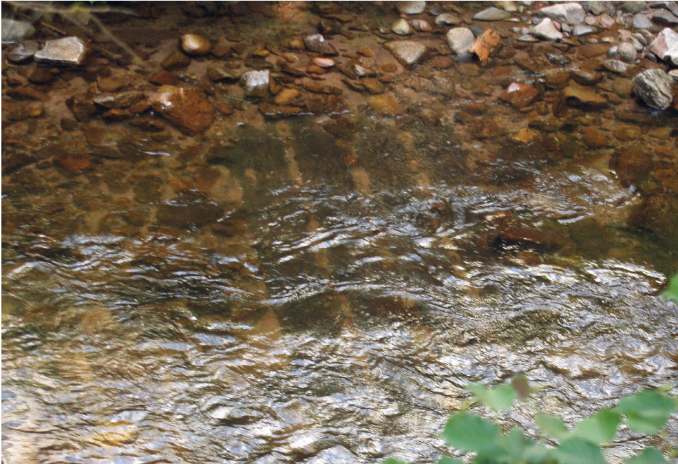
Abb. 69: Sohlenverbau mit Holzbohlen im Dammbereich des ehemaligen Schappenweihers in der Wolf in Vor Wildschapbach unterhalb des Sägewerks Schmid-Holz. Foto: Christian Suchomel.
