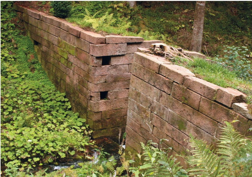
Abb. 74: Damm des Oberen Layweihers im Kaltbrunner Tal. Foto: Werner Konold.
