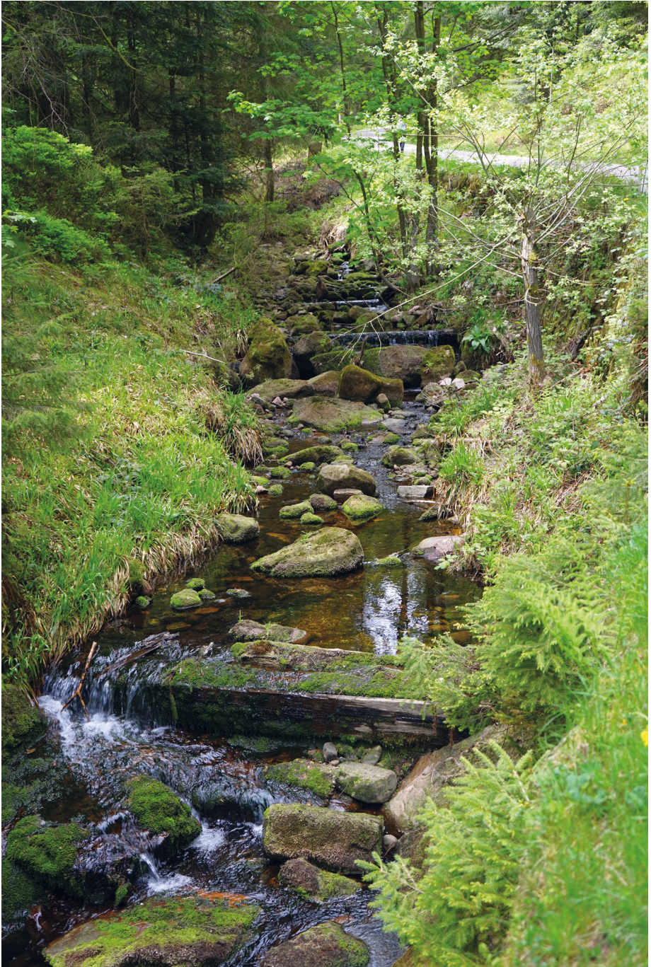
Abb. 59: Sohlschwellen im Seebach oberhalb des Wanderparkplatzes, der ehemaligen Spannstatt. Foto: Werner Konold.
