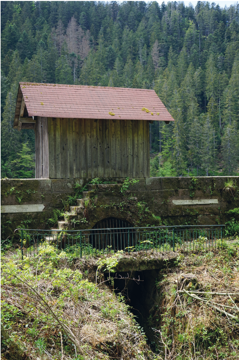
Abb. 53: Das Ablassbauwerk am Glaswaldsee. Foto: Werner Konold.
