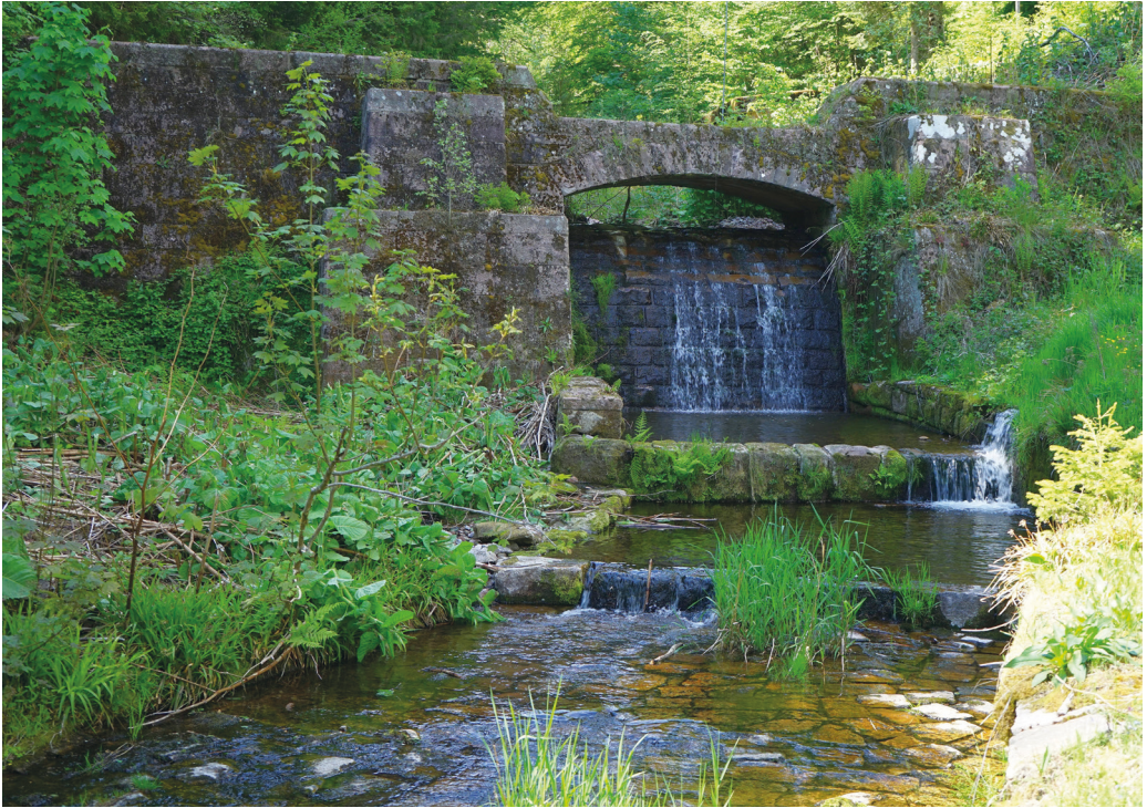
Abb. 64: Der Wolfenweiher an der oberen Wolfach. Unterhalb des Absturzes befindet sich das Tosbecken. Die Bachsohle ist noch ein ganzes Stück weit gepflastert. Foto: Werner Konold.
