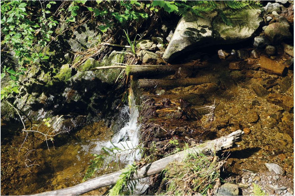
Abb. 88: Querbauwerk mit Absturz im Dollenbach. Foto: Werner Konold.
