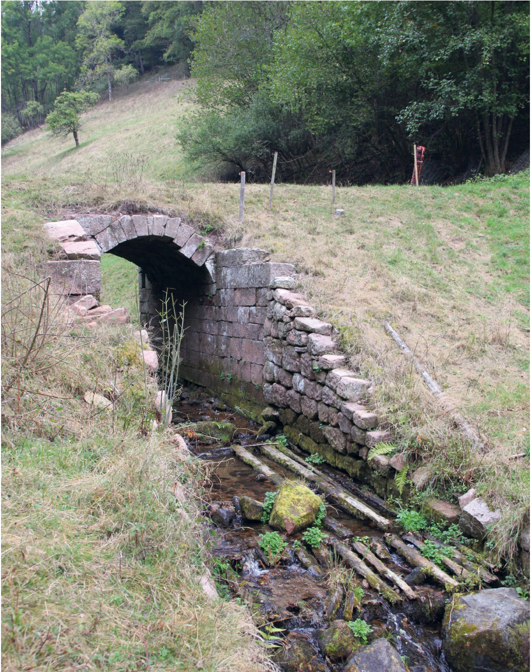
Abb. 55: Damm des Witticher Floßweihers mit Holzpritsche, vom Unterwasser aufgenommen. Foto: Werner Konold.
