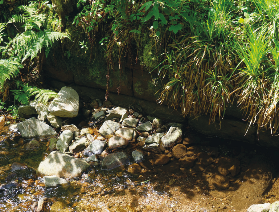
Abb. 86: Steinmauer auf Holzbalken im Schwabach; eine Technik, wie sie in den historischen Quellen beschrieben wird. Foto: Werner Konold.
