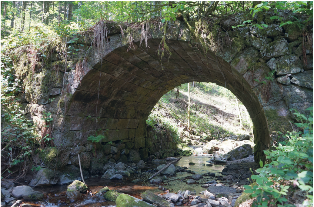
Abb. 80: Brücke im Wildschapbachtal mit großem Durchlass. Foto: Werner Konold.
