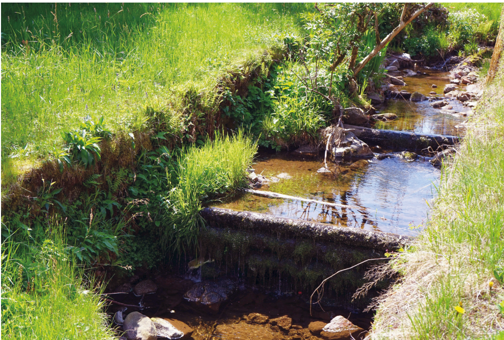
Abb. 91: Ufermauer und Holzschwellen im Schembach. Foto: Werner Konold.
