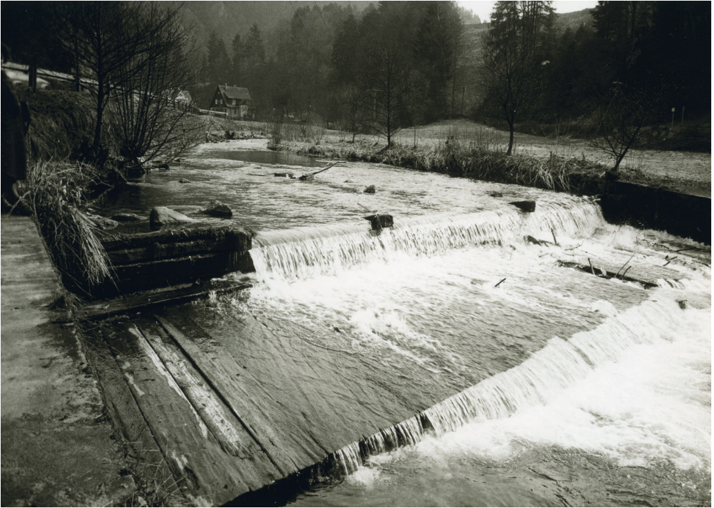
Abb. 48: Wehr Nr. 18 beim Hinterbauer für die Wolbermühle. Aufnahme von Oskar Roth, 1982, StA Schramberg. Bei einem Hochwasser am 23./24.12.1919 wurde das alte Wehr weggerissen. Das neue wurde etwas unterhalb erbaut. Im Baugesuch von 1920 heißt es, wegen des herrschenden Baustoffmangels solle das Wehr ganz aus Holz erbaut werden. „An den Flussufern sollen die Wehrbäume umpflastert werden. Der Aufsatz über der Wehrschwelle soll 0,60 m betragen und ganz beweglich gemacht werden. Die Breite der Flossgasse soll 4,50 m betragen [die Flößerei war schon längst aufgegeben!]. Das Öffnen der Flossgasse erfolgt mittelst einer sog. Schnapperstange [vgl. „Schnapperle“] mit einem ungefähren Durchmesser von 18 cm. Die beiderseitigen Aufsätze werden mittelst Kette am Ufer befestigt“ (wie Anm. 199).
