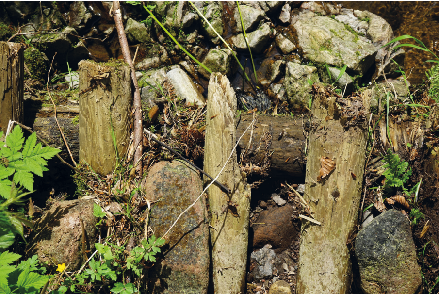
Abb. 87: Ufersicherung am Dollenbach. Foto: Werner Konold.
