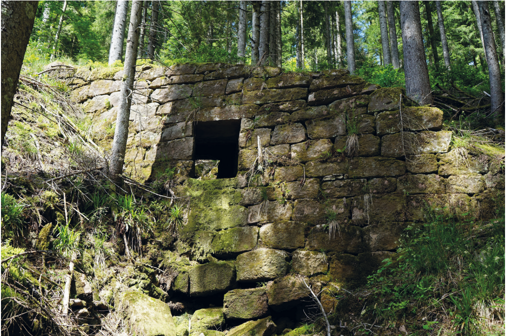
Abb. 34: Steinkonstruktion als Riesunterbau zum Überbrücken eines Bacheinschnitts (Hinterer Absbach). Foto: Werner Konold.
