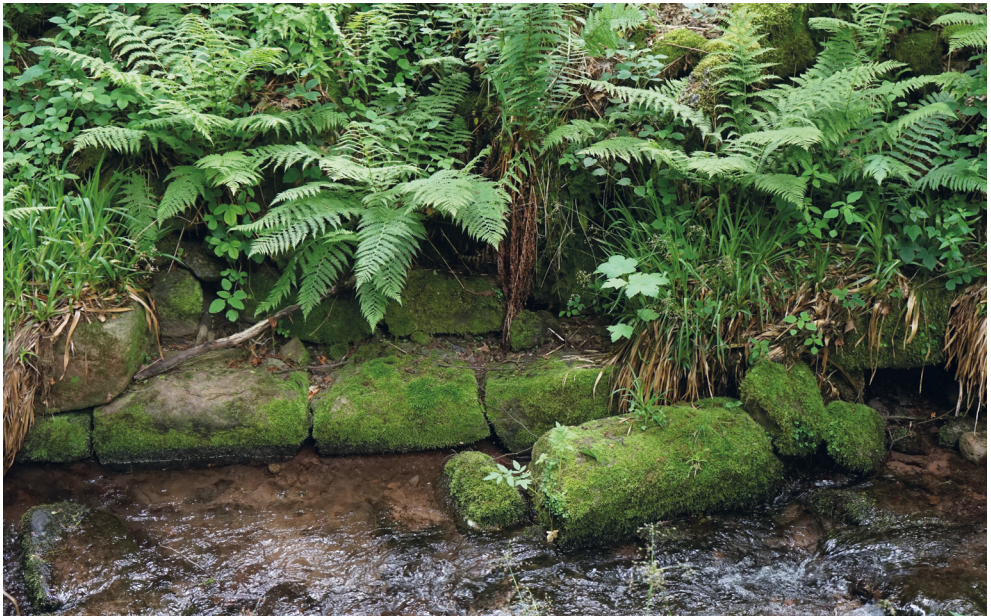
Abb. 71: Ufermauer unterhalb des Tierweiherdamms. Foto: Werner Konold.
