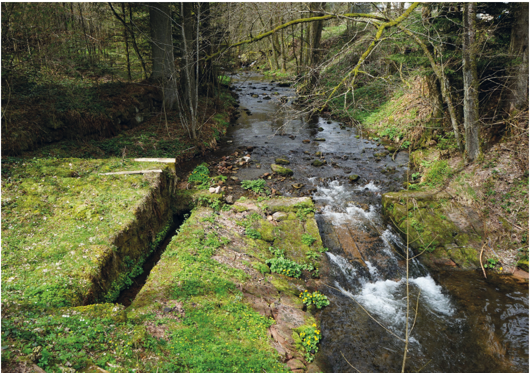
Abb. 16: Mühlenausleitung zur Oberen Mühle und Floßgasse am Lohmühlbach. Foto: Werner Konold.
