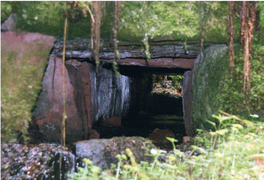
Abb. 32: Durchlass für einen Bach durch den Steinbau einer Riese im Witticher Tal. Foto: Werner Konold.
