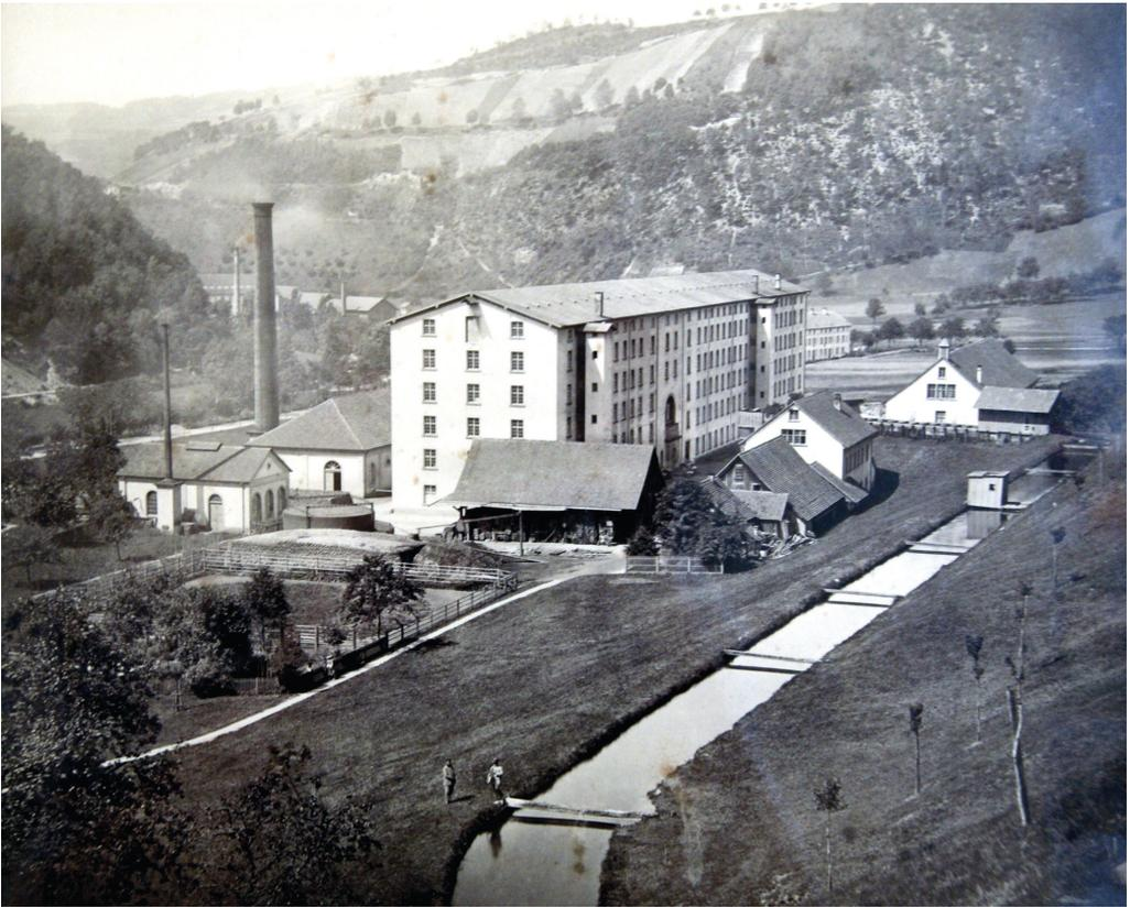
Abb. 51: Der Atzenbacher Gewerbekanal als Energielieferant für die Spinnerei, unter deren Nebengebäuden die Gasbereitungsanlage mit Gasometer auffällt. Eingezäuntes Grundstück: vermutlich eine Pferdekoppel zwischen Fabrik und nahem Direktorenhaus. Foto um 1885. Archiv Wiesentäler Textilmuseum Zell i. W.
