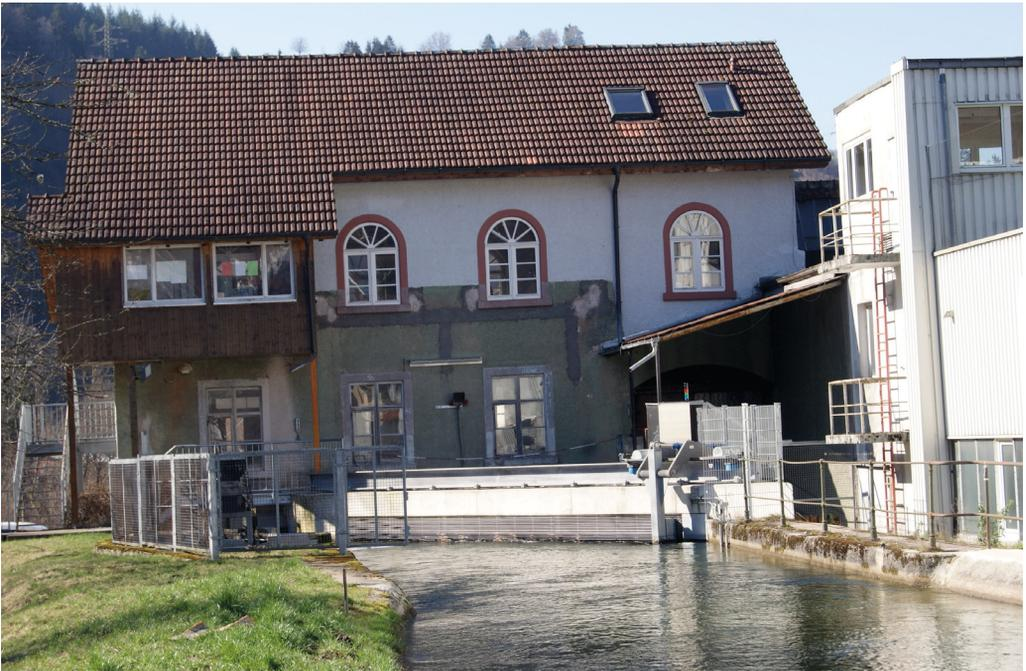
Abb. 71: Das heute von Energiedienst betriebene Kleinwasserkraftwerk am Zeller Gewerbekanal nutzt eine Fallhöhe von 5,8 m zur Stromgewinnung mit einer Jahresleistung von 1,1–1,4 Mio. kWh. Rückleitung des Wassers in die Wiese, da unterer Kanalabschnitt zugeschüttet. Foto: Cornelia Korff 2019.
