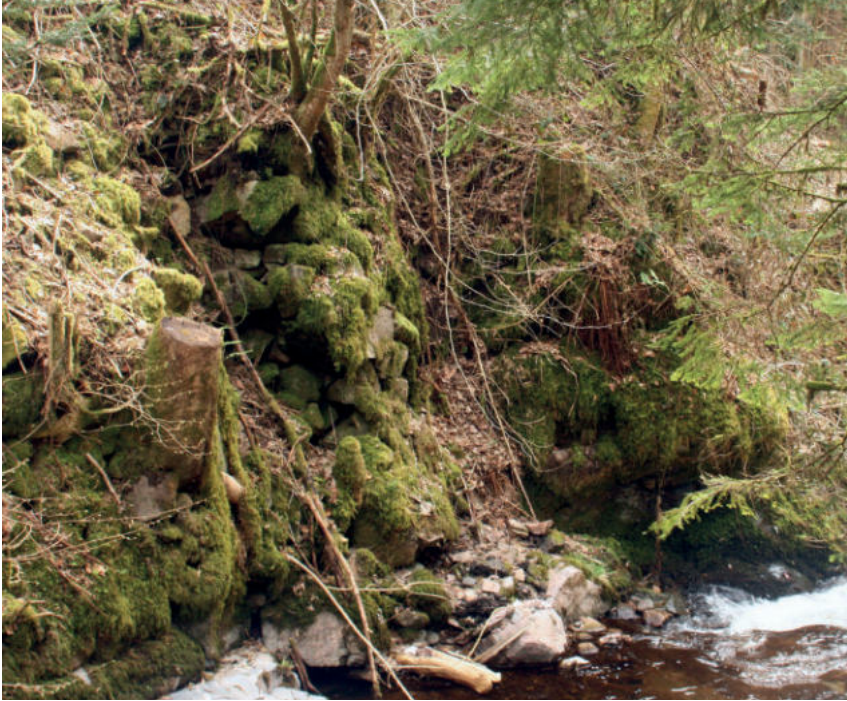
Abb. 73: Dammreste eines Floßweihers im Heubach im Gewann „Am Weihermättle“. Foto: Christian Suchomel.
