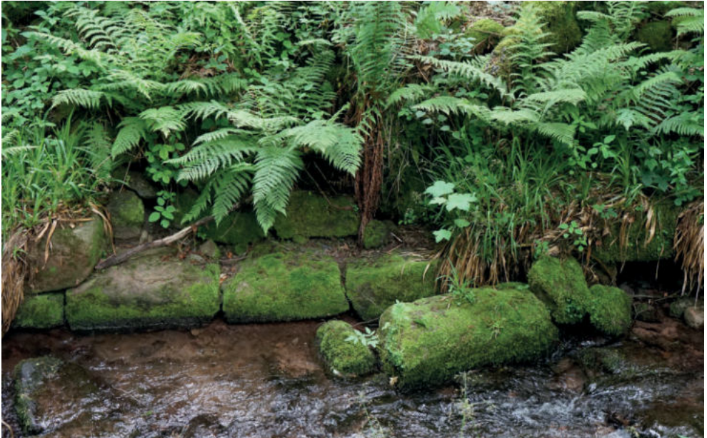
Abb. 71: Ufermauer unterhalb des Tierweiherdamms. Foto: Werner Konold.
