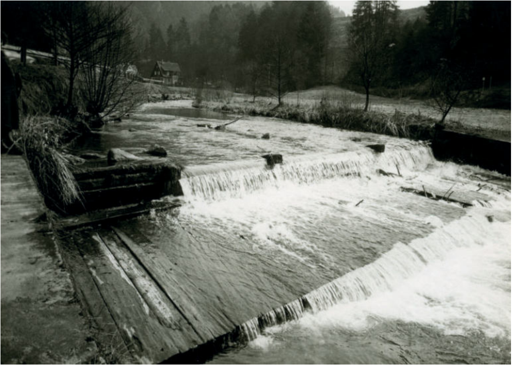
Abb. 48: Wehr Nr. 18 beim Hinterbauer für die Wolbermühle. Aufnahme von Oskar Roth, 1982, StA Schramberg. Bei einem Hochwasser am 23./24.12.1919 wurde das alte Wehr weggerissen. Das neue wurde etwas unterhalb erbaut. Im Baugesuch von 1920 heißt es, wegen des herrschenden Baustoffmangels solle das Wehr ganz aus Holz erbaut werden. „An den Flussufern sollen die Wehrbäume umpflastert werden. Der Aufsatz über der Wehrschwelle soll 0,60 m betragen und ganz beweglich gemacht werden. Die Breite der Flossgasse soll 4,50 m betragen [die Flößerei war schon längst aufgegeben!]. Das Öffnen der Flossgasse erfolgt mittelst einer sog. Schnapperstange [vgl. „Schnapperle“] mit einem ungefähren Durchmesser von 18 cm. Die beiderseitigen Aufsätze werden mittelst Kette am Ufer befestigt“ (wie Anm. 199).
