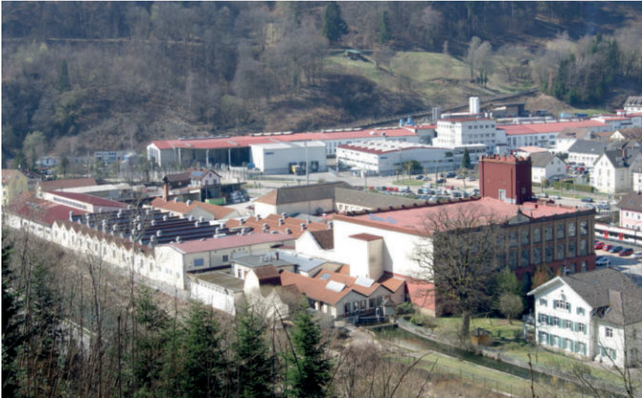
Abb. 77: Ehemaliges Fabrikareal der einstigen Spinnerei und Zwirnerei Feßmann & Hecker. Ursprünglicher Standort der in J. M. Morats Ansichten belegten Handweberei, später mechanischen Spinnerei der Unternehmer Koechlin, auf die Teile der Shedbauten, Kanal und Firmenvilla (rechts) zurückgehen. Foto: Cornelia Korff 2019.
