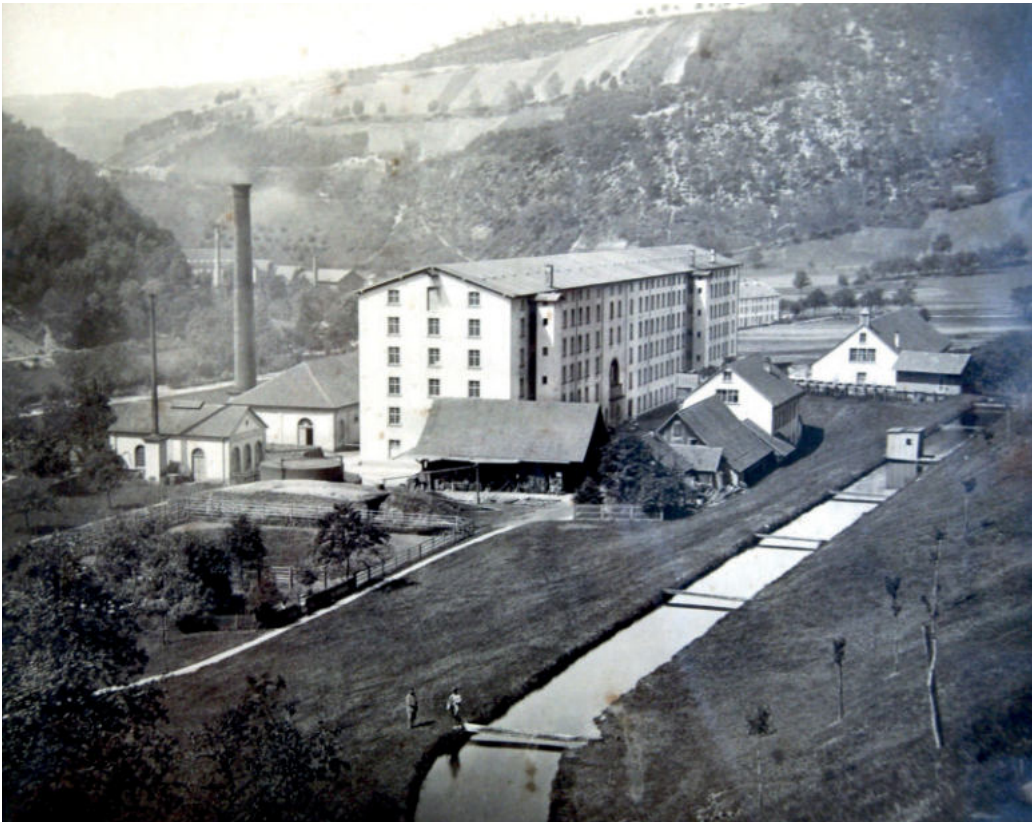
Abb. 51: Der Atzenbacher Gewerkanal als Energielieferant für die Spinnerei, unter deren Nebengebäuden die Gasbereitungsanlage mit Gasometer auffällt. Eingezäuntes Grundstück: vermutlich eine Pferdekoppel zwischen Fabrik und nahem Direktorenhaus. Foto um 1885. Archiv Wiesentäler Textilmuseum Zell i. W.
