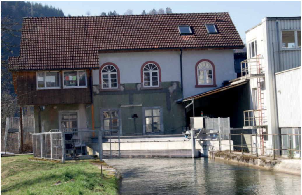
Abb. 71: Das heute von Energiedienst betriebene Kleinwasserkraftwerk am Zeller Gewerbekanal nutzt eine Fallhöhe von 5,8 m zur Stromgewinnung mit einer Jahresleistung von 1,1–1,4 Mio. kWh. Rückleitung des Wassers in die Wiese, da unterer Kanalabschnitt zugeschüttet. Foto: Cornelia Korff 2019.
