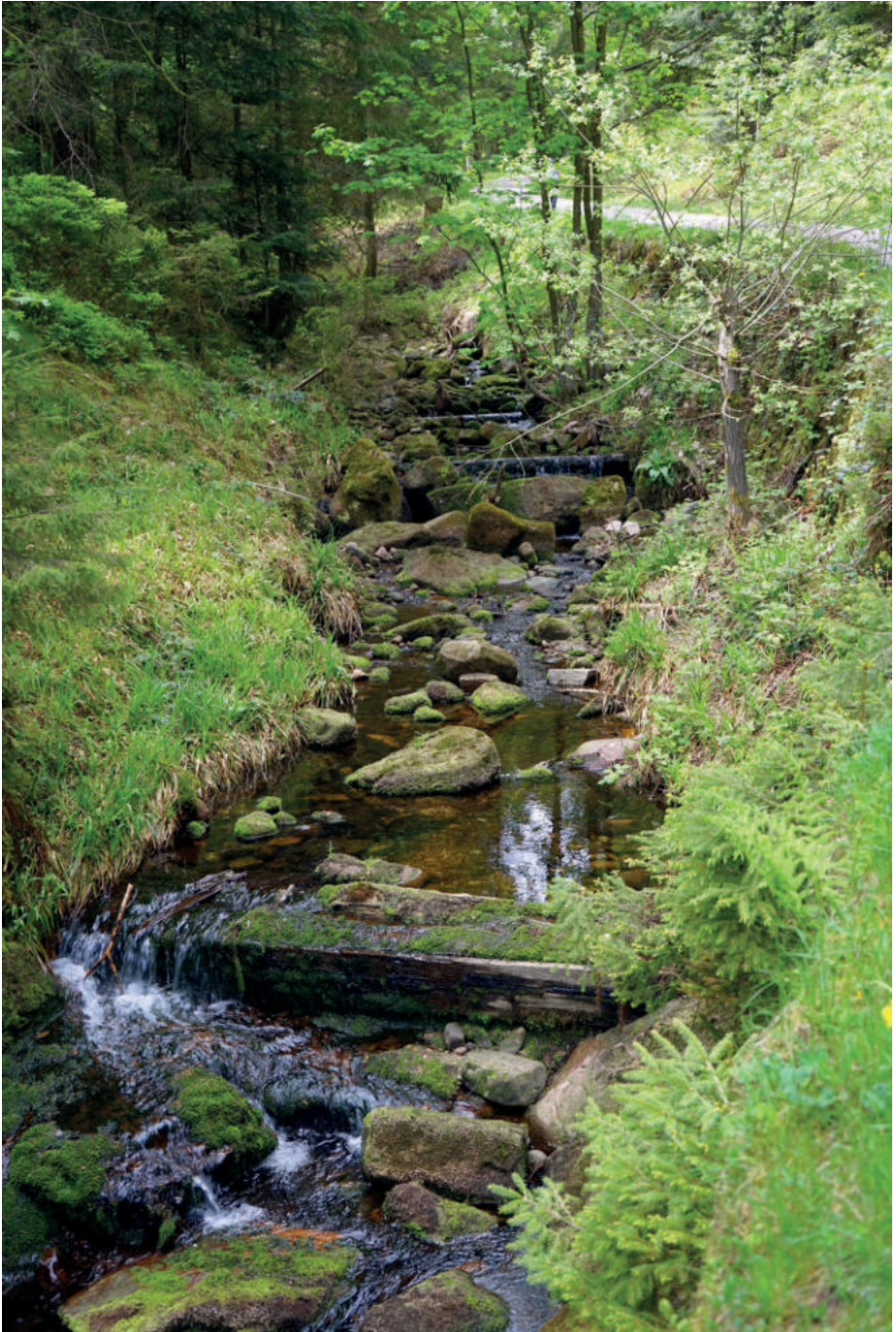
Abb. 59: Sohlschwellen im Seebach oberhalb des Wanderparkplatzes, der ehemaligen Spannstatt. Foto: Werner Konold.
