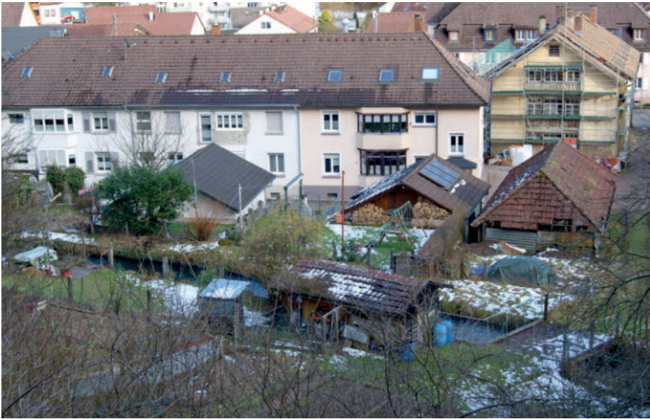
Abb. 58: Ehemaliges Meisterhaus der Spinnerei Atzenbach im Oberdorf (Rückansicht) mit Gärten und Schuppen. Nach Privatisierung unterschiedliche Lösungen bei Fassaden- und Laubengestaltung. Foto: Cornelia Korff 2020.
