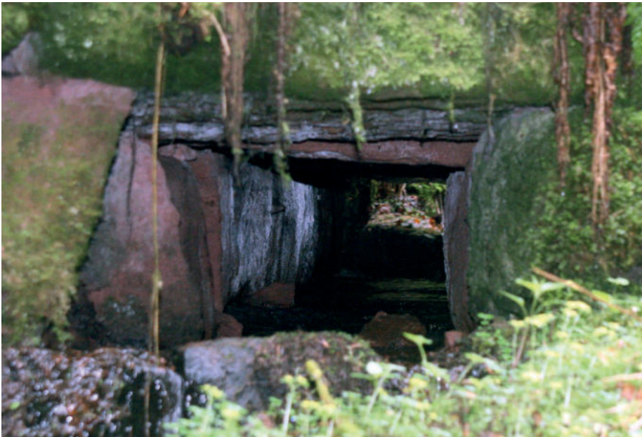
Abb. 32: Durchlass für einen Bach durch den Steinbau einer Riese im Witticher Tal. Foto: Werner Konold.
