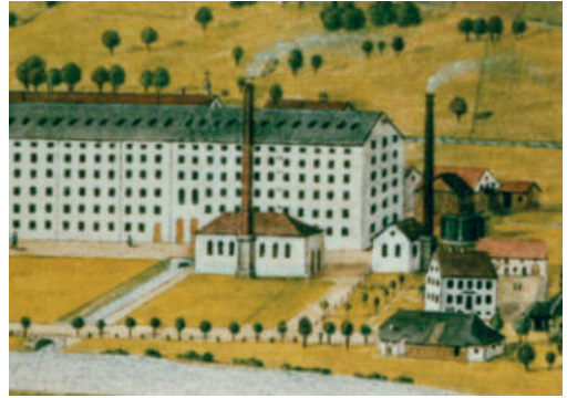
Abb. 30: Vergrößerter Ausschnitt aus einer Ortsansicht von J. M. Morat um 1864. Eine Gasbereitungsanlage mit zweitem Kesselhaus, Kamin und Gasometer (schwarzer zylindrischer Block) ergänzt die Energieversorgung der Spinnerei Atzenbach. Davor rechts das Gasthaus Sonne und strohgedeckte „Arche“. Johann Martin Morat, Gouache (undatiert, vermutlich 1863/64). Foto: Ulrich Schwarz, Heimatsammlung Ulrich Schwarz, ohne Hinweis auf das Original.
