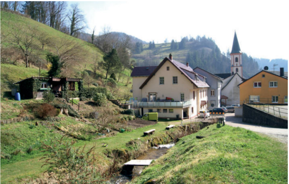
Abb. 76: Ehemaliges Montfort-Mühlengebäude am Himmelsbach in Zell. Die 1905 an S. Kern verpachtete Mühle wurde bis nach dem Zweiten Weltkrieg betrieben. Im Tiefkeller des heutigen Wohnhauses gut erhaltene Turbinenanlage (vgl. Abb. 18). Foto: Cornelia Korff 2020.
