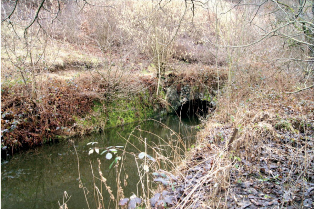
Abb. 29: Der zwischen Mambach und Atzenbach aus der Wiese abgeleitete Gewerbekanal der Spinnerei Atzenbach durchfließt zwei Tunnelstrecken. Hier: Stollenausgang nach dem zweiten Tunnel oberhalb des Fabrikgeländes. Foto: Cornelia Korff 2019.
