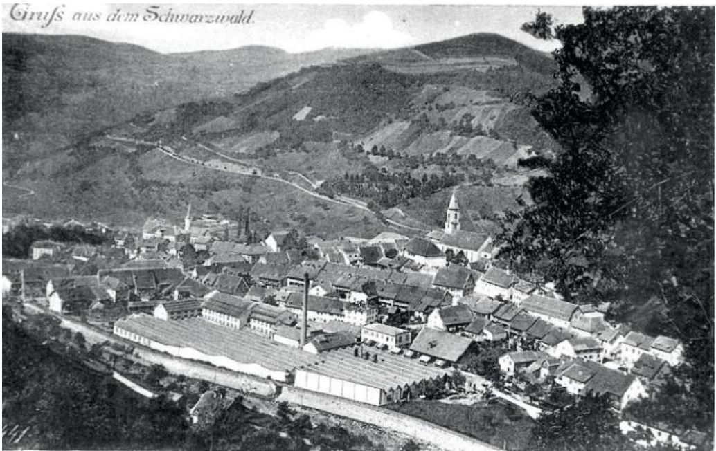
Abb. 39: Fabrikareal der Mechanischen Weberei Zell in den 1890er Jahren: Weitläufige Shedhallen füllen den Raum zwischen dem Koechlin'schen Webereibau (mit Anbau und Kraftwerk) sowie der Trasse des „Todtnauerli“ auf dem Wieseufer. Heimatsammlung Ulrich Schwarz / Zell i. W.
