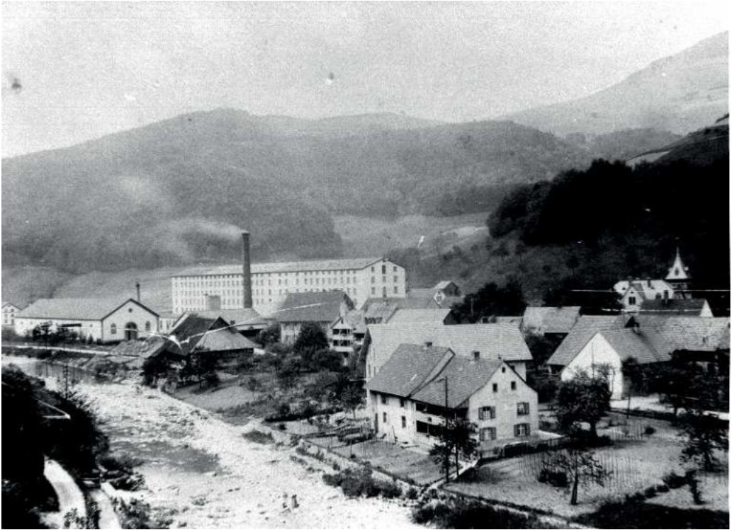
Abb. 62: Am Standort der von J. M. Morat belegten Atzenbacher Fronmühle ist der Anbau zu einem Wohnhaus mit Lauben erweitert worden. Das mit Werkwohnungen der Spinnerei (Hintergrund) belegte Ensemble wick 1978 einer Neubebauung. Heimatsammlung Ulrich Schwarz / Zell i. W., undatierte Aufnahme aus dem ersten Drittel des 20. Jahrhunderts.
