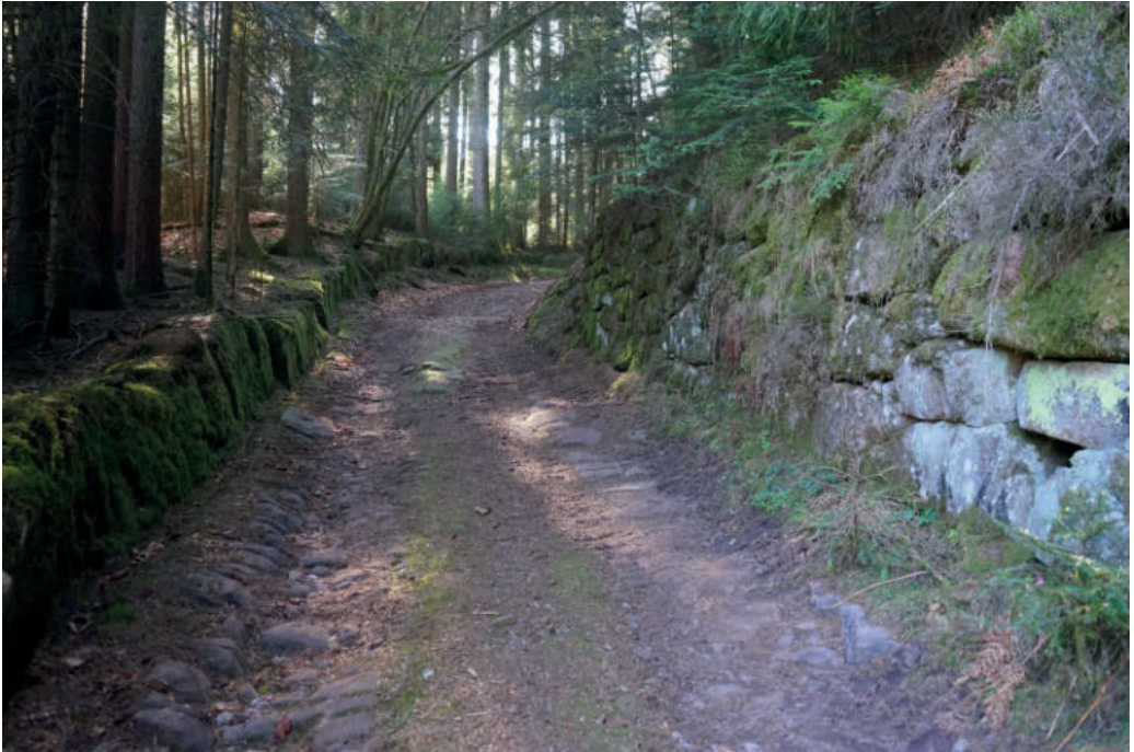
Abb. 27: Riese Roßbergsteige mit Pflasterung und talseitiger Mauer. Foto: Werner Konold.
