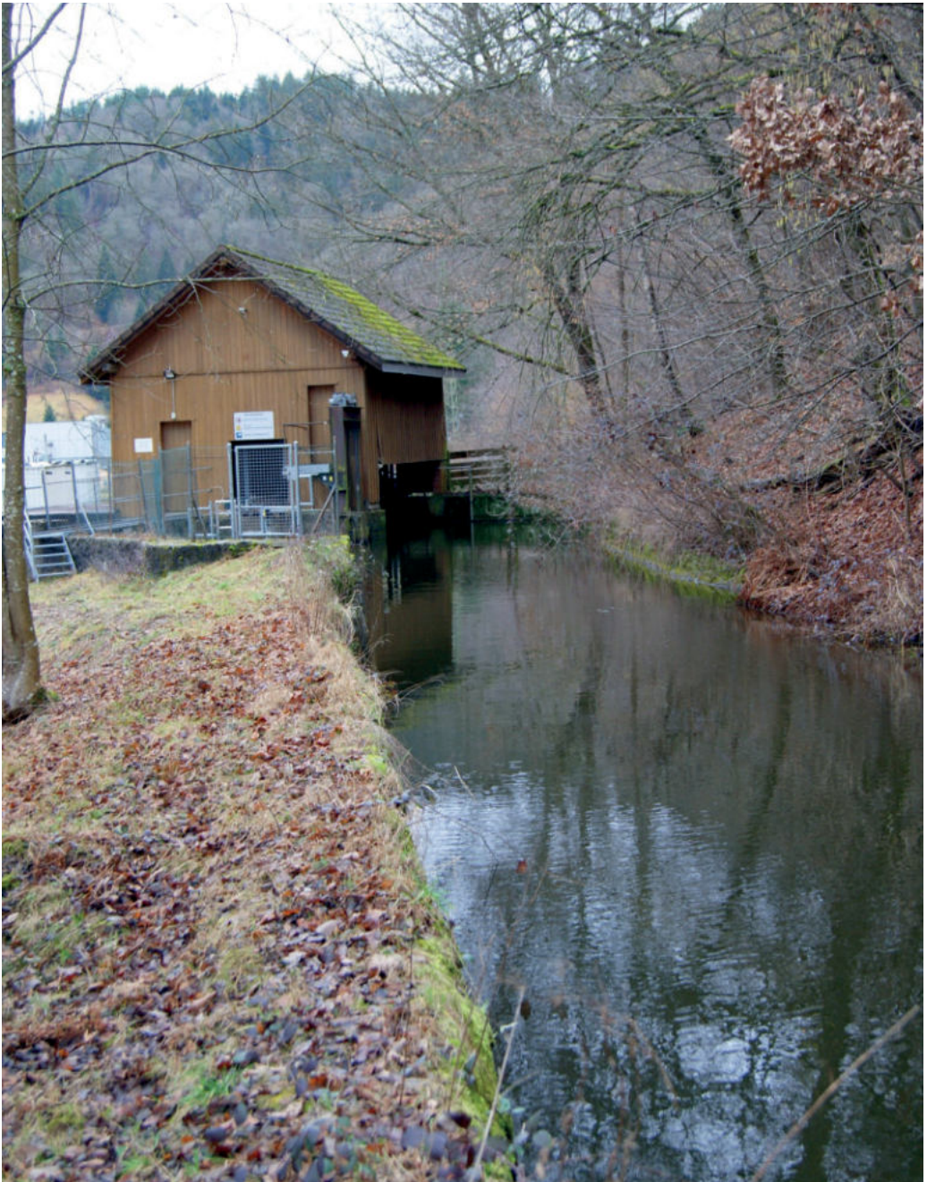
Abb. 72: Das Wasserkraftwerk der Spinnerei Atzenbach nutzte die Fallhöhe von 11,8 m zwischen Gewerbekanal (mit Rechenhäuschen) und Turbinenanlage bis 1936 für den mechanischen Direktantrieb, danach über Stromerzeugung. Heute betrieben von Energiedienst (Jahresleistung 3,2–3,6 Mio. kWh). Foto: Cornelia Korff 2019.
