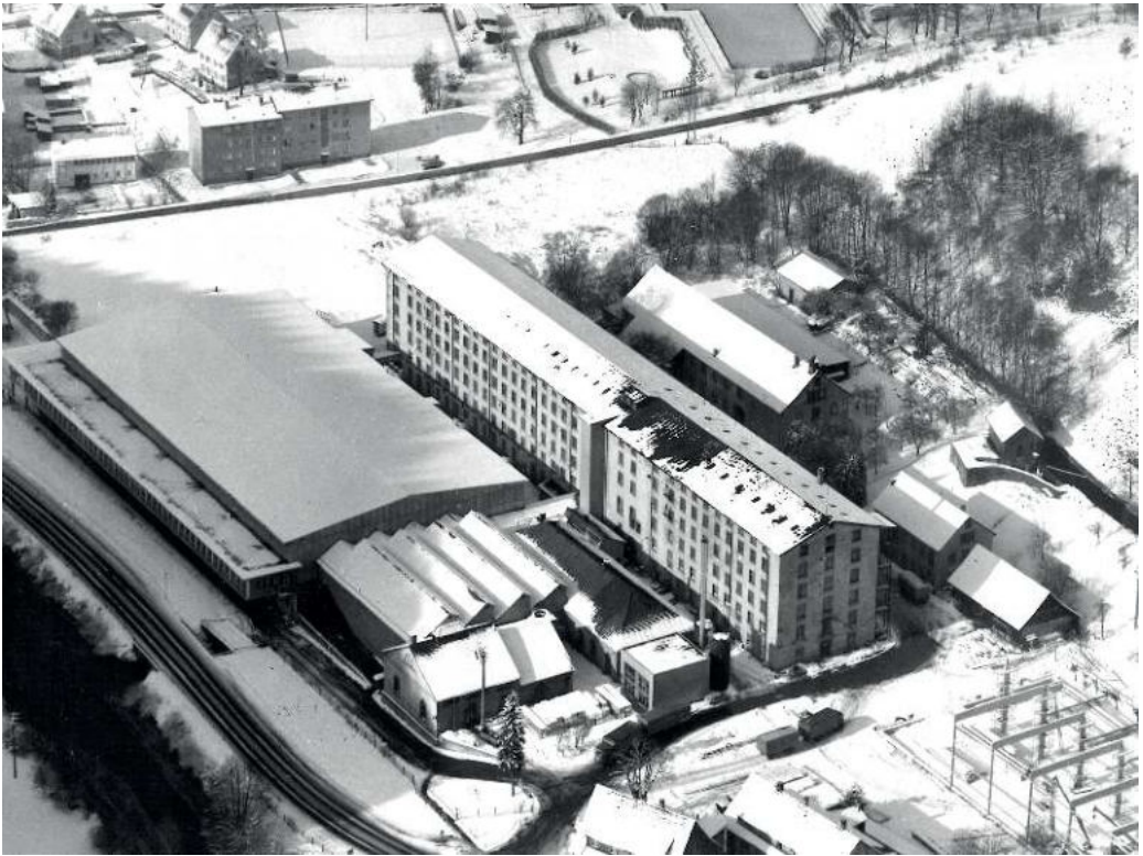
Abb. 56: 1958 verlagerte man die Garnproduktion aus dem Traditionsbau in den Spinnereiflachbau davor. In den Shedhallen daneben das Vorwerk, außerdem Kesselhaus und Heizanlage. Im Altbau Lager und Versand. Nach Stilllegung der Bahn (1967) alle Transporte durch LKWs. Sammlung Hans Jungel / Zell-Atzenbach.
