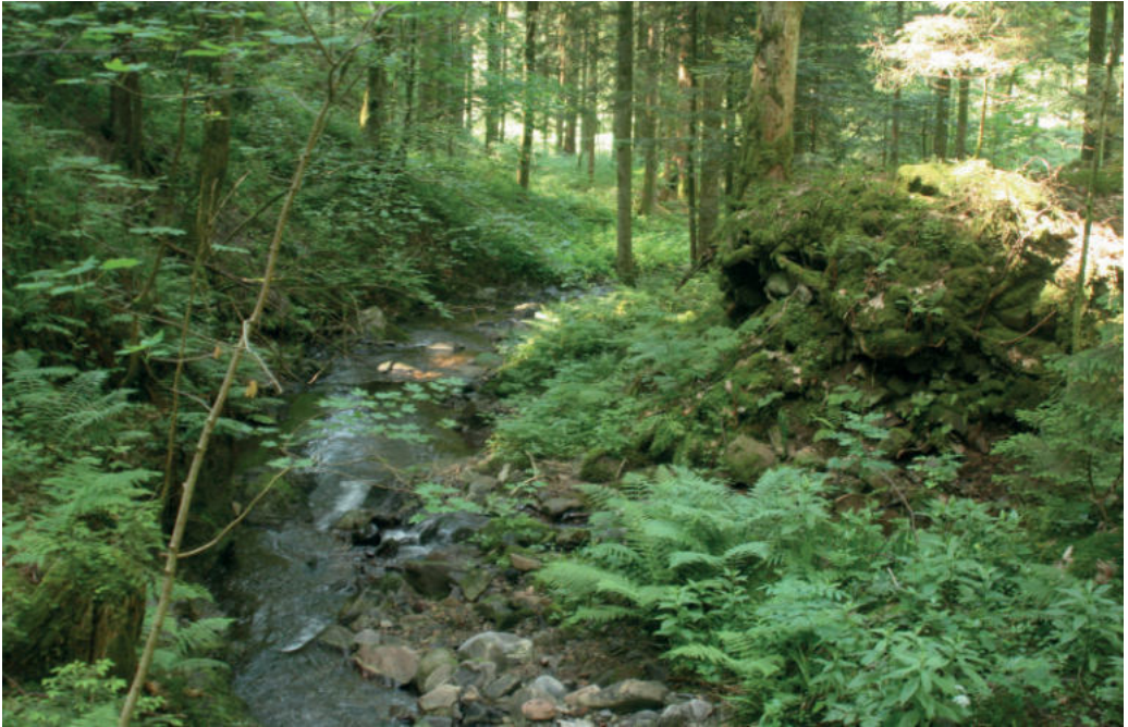
Abb. 66: Der untere Staudamm des Hinteren Weihers am Wildschapbach. Er besteht aus geschütteten Steinen. Foto: Christian Suchomel.
