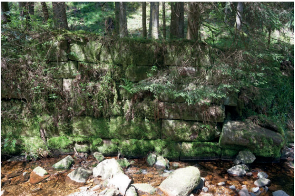
Abb. 85: Ufermauer am hinteren Absbach. Hinter der Mauerkrone ist das Gelände entlang der Mauer etwas erhöht, was an einen Weg erinnern lässt; dahinter befindet sich eine Verebnung, die eigens – etwa für die Stammholzlagerung – angelegt worden sein könnte. Foto: Werner Konold.
