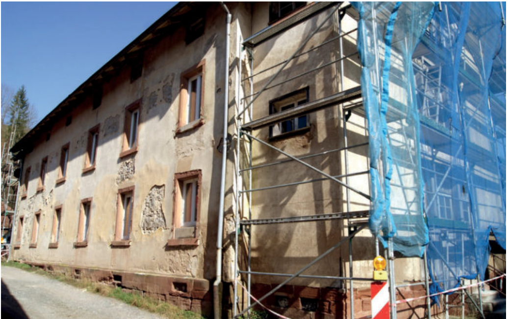
Abb. 57: Die langgestreckten Laborantenhäuser in Atzenbach hatten durchweg acht Wohnungen mit Lauben auf der Rückseite, dazu Gärten zur Selbstversorgung. Das zur ersten Generation der Laborantenhäuser zählende und bei J. M. Morat dokumentierte Gebäude (vgl. Abb. 31) lässt zwischen den Fenstern unterhalb des entfernten Verputzes die ursprüngliche Bausubstanz aus Bruchsteinen erkennen. Foto: Cornelia Korff 2020.
