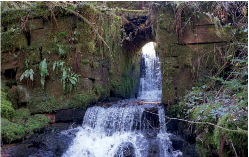
Abb. 76: Damm des Rötzbächleweiher im hinteren Rötzbächle. Foto: Werner Konold.
