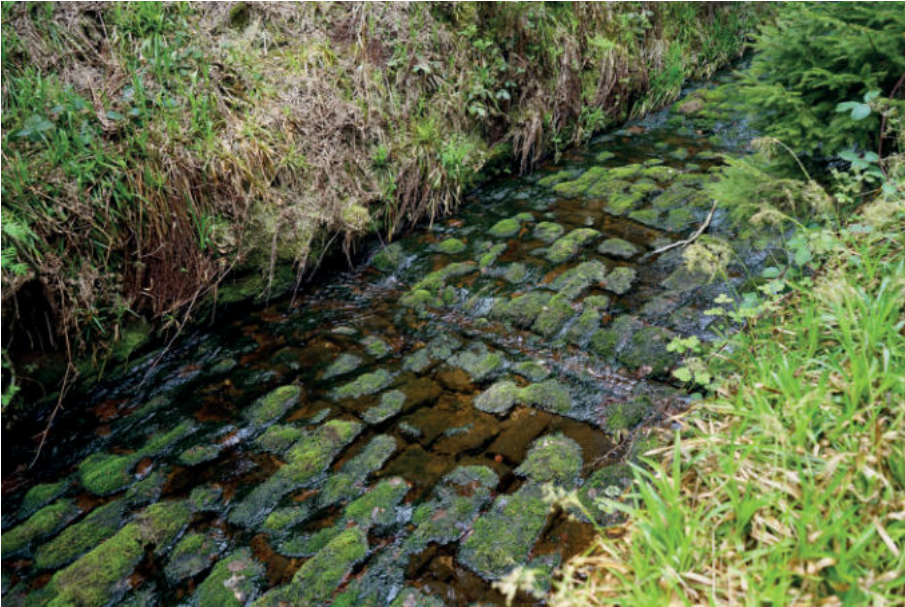
Abb. 60: Gut erhaltenes Sohlpflaster im Seebach. Foto: Werner Konold.
