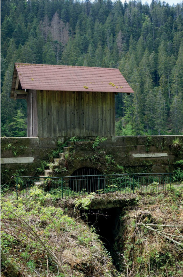
Abb. 53: Das Ablassbauwerk am Glaswaldsee. Foto: Werner Konold.
