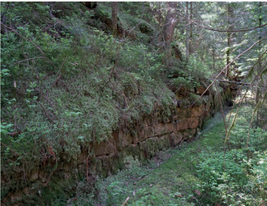
Abb. 61: Riese mit eindrucksvollen tal- und bergseitigen Stützmauern oberhalb der Spannstatt. Foto: Werner Konold.
