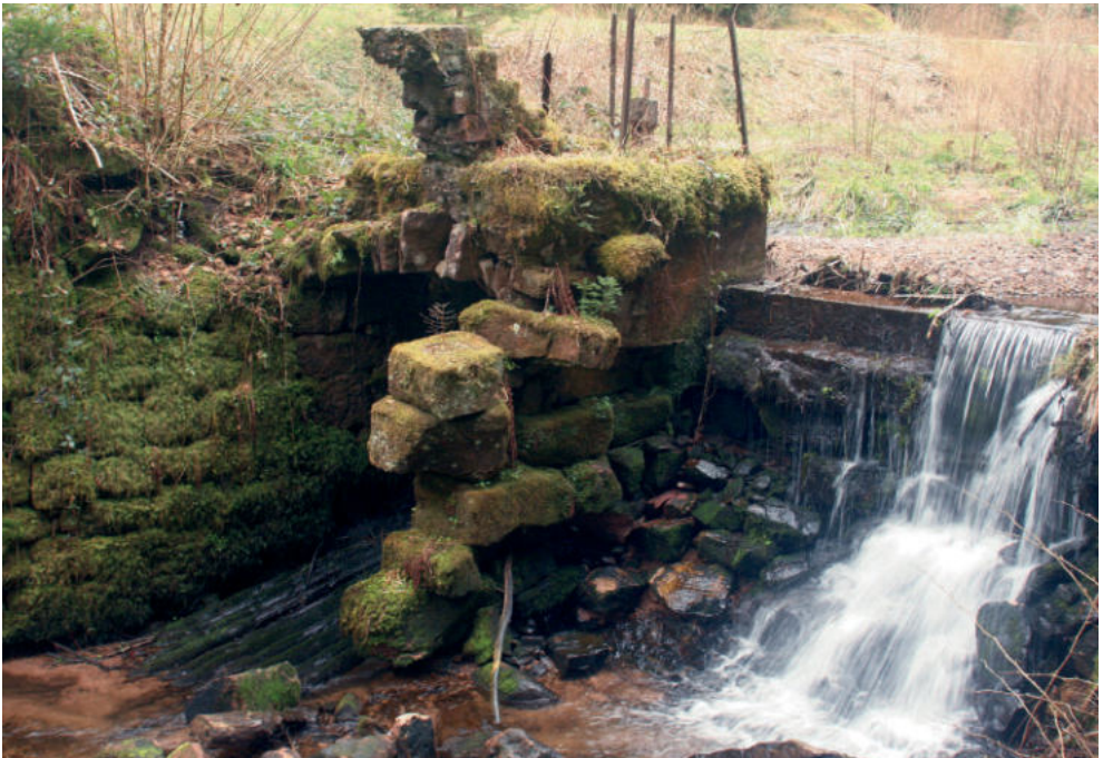
Abb. 72: Schwallung im Ochsengrund, Heubachtal; am Durchlass ist eine Holzpritsche zu erkennen. Foto: Christian Suchomel.
