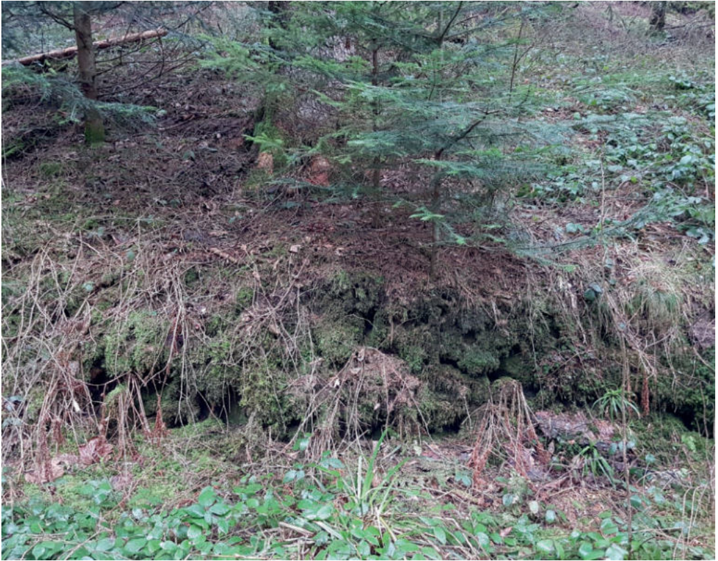
Abb. 40: Hangseitige Stützmauer der Ochsengrundspannstatt im Heubachtal. Foto: Werner Konold.
