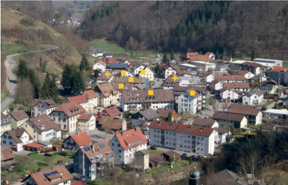
Abb. 73: Im Atzenbacher Oberdorf führte der Bau von Werkswohnungen in Laboranten- (gelbes Quadrat) und Meisterhäusern (gelber Stern) der Spinnerei zur Siedlungsverdichtung des ursprünglich weilerartig lockeren Ortsteils (vgl. Abb. 31 und 59). Foto: Cornelia Korff 2020.
