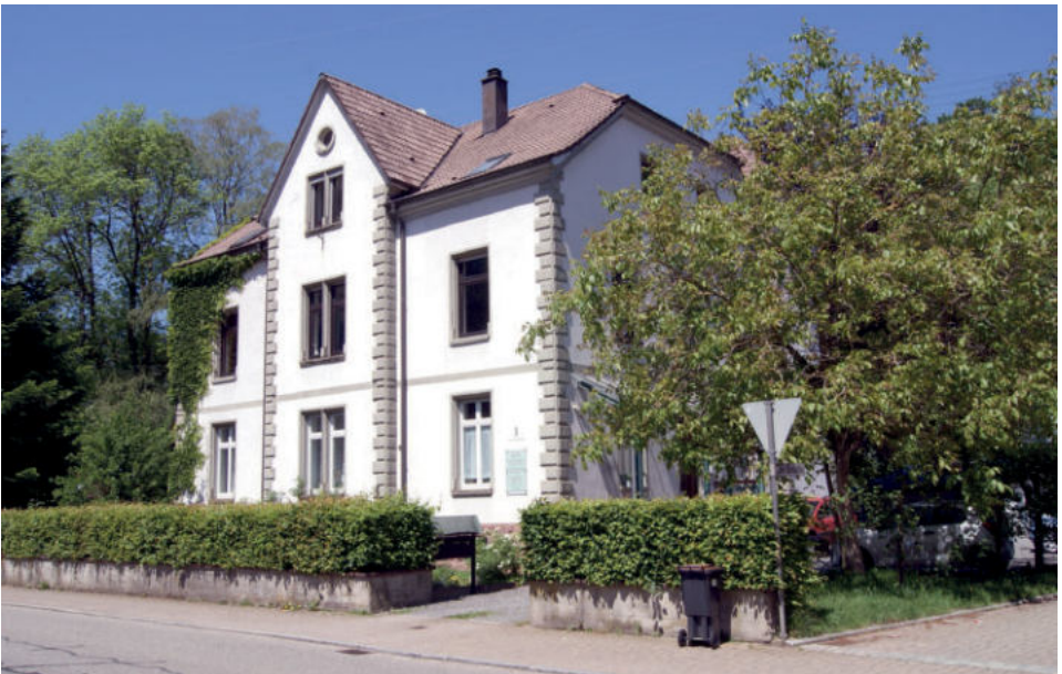
Abb. 61: Das „Schlössle“ wurde 1870/1871 als neues Direktorenhaus errichtet, 1938 grundrenoviert und 1978 von der Zell-Schönau AG an Privat verkauft. Einziges Gebäude im Stil einer Unternehmervilla in Atzenbach. Foto: Cornelia Korff 2020.
