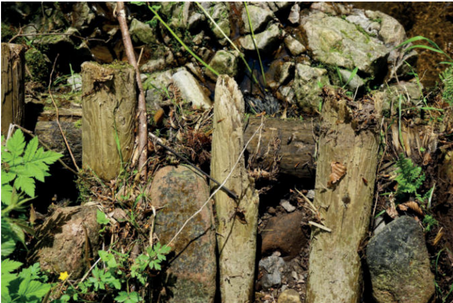
Abb. 87: Ufersicherung am Dollenbach. Foto: Werner Konold.
