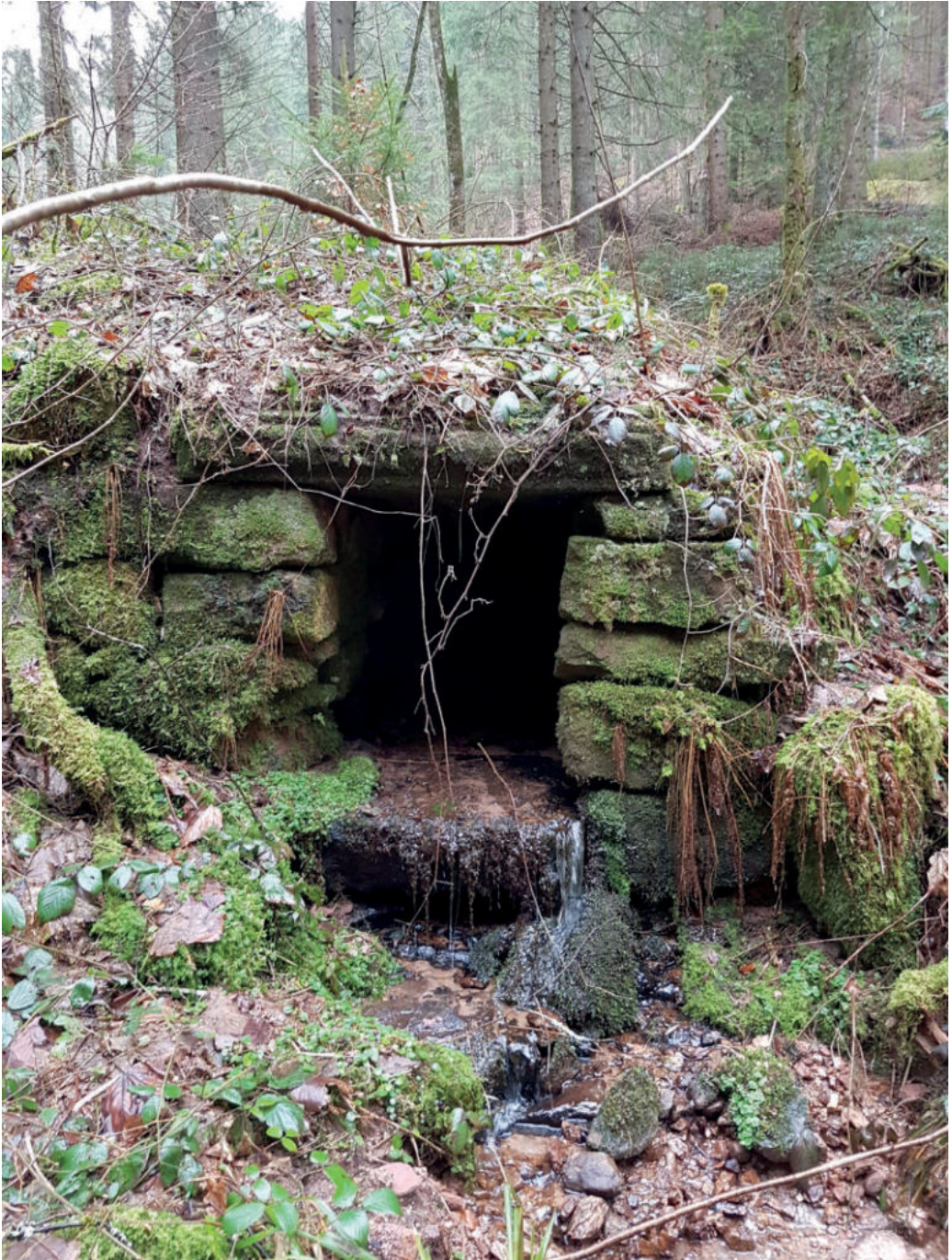
Abb. 41: Durchlass eines Seitenbachs unter der Ochsengrundspannstatt im Heubachtal. Foto: Werner Konold.
