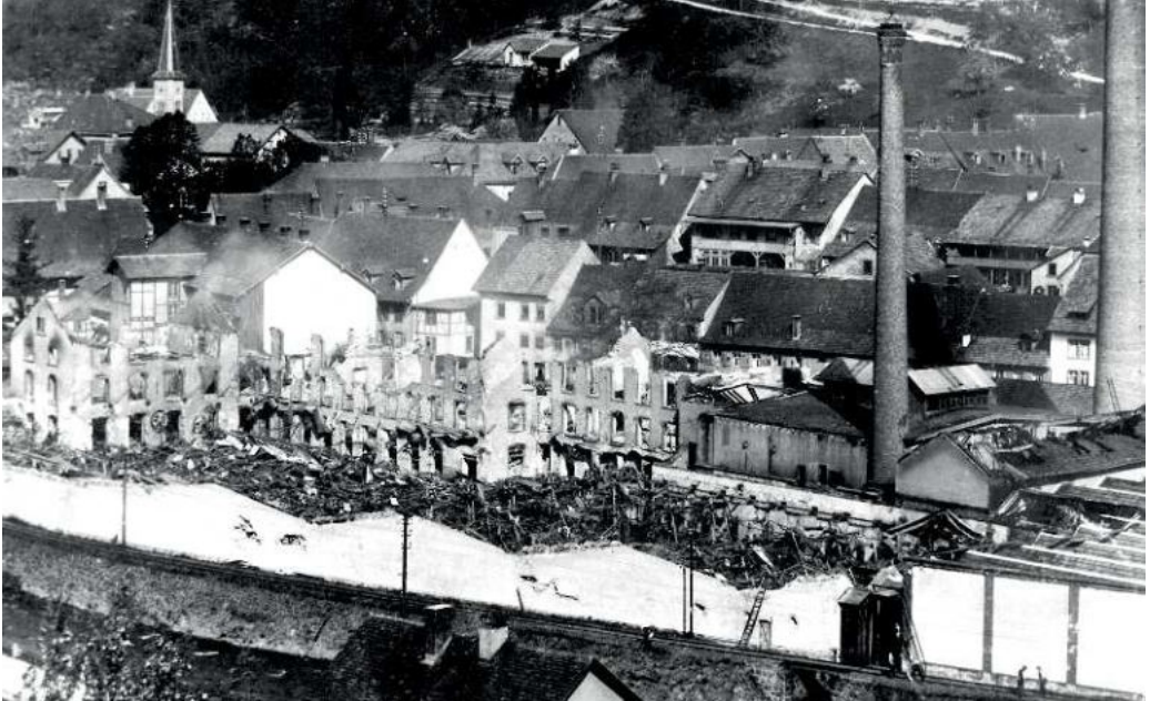
Abb. 45: Ein Großbrand vernichtete 1908 die meisten Shedhallen der Mechanischen Weberei Zell bis hin zur Bahntrasse sowie den Koechlin'schen Webereibau und einige Magazine. Während des zügigen Wiederaufbaus lief die Produktion eingeschränkt weiter. Heimatsammlung Ulrich Schwarz / Zell i. W.
