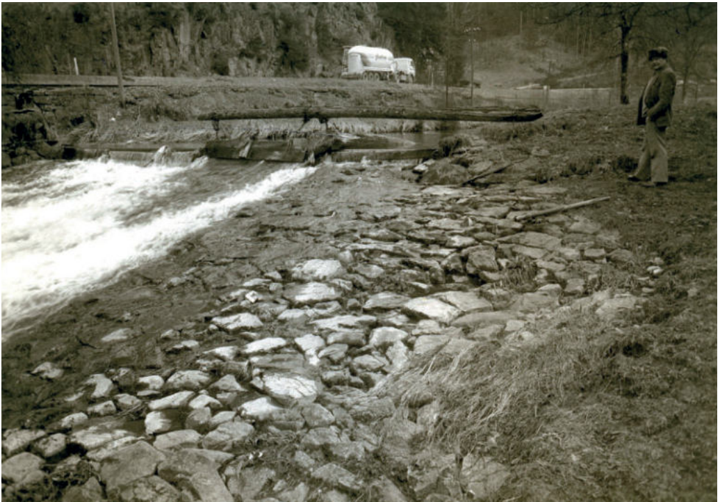
Abb. 46: Hofsägwehr beim Hofbauer, Wehr mit Fahrloch und Gamper. Aufnahme von Oskar Roth, 1982, StA Schramberg.
