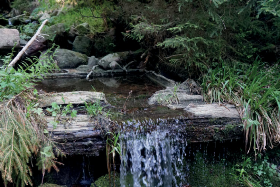
Abb. 90: Querbauwerk in der Dürren Kinzig. Foto: Werner Konold.
