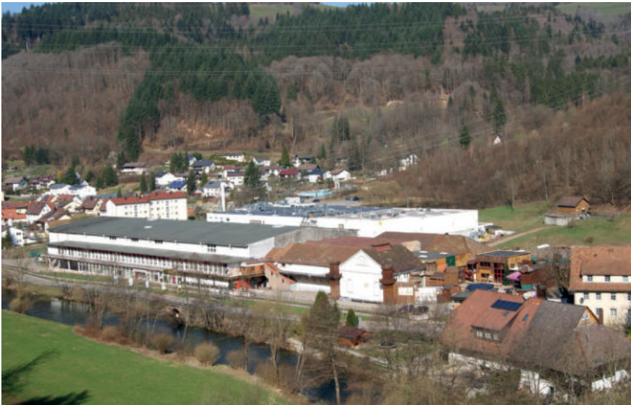
Abb. 78: Auf dem Gelände der ehemaligen Spinnerei Atzenbach wurde ein Zweigwerk der Firma Hella angesiedelt – Flachbau im Hintergrund. Davor hat sich im einstigen Spinnereiflachbau aus dem Jahre 1958 ein Westernfreizeitpark etabliert, zu dem auch Altbauten (ältestes Kesselhaus, verdeckt) gehören, die ebenso wie die Arche und das ehemalige Gasthaus Sonne (rechter Bildrand) schon durch J. M. Morat belegt worden sind. Foto: Cornelia Korff 2020.
