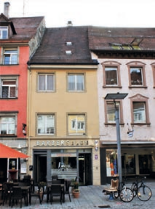
Abb. 12: Villingen, Ansicht Obere Straße 25. Links der an der nachbarlichen Brandwand liegende Hauseingang mit anschließendem Hausgang. Rechts der Eingang in den Laden.
