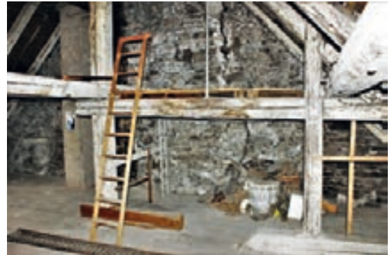
Abb. 9b: Villingen, Bickenstraße 9, Ausschnitt der um 1338(d) errichteten Dachkonstruktion. Rechts die Auflagerung des Rofenunterzuges auf dem oberen Binderbalken. Blick in Richtung Haus Nr. 7.
