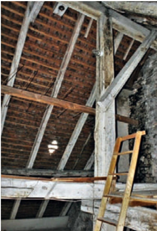
Abb. 9a: Villingen, Bickenstraße 9, Ausschnitt der um 1338(d) errichteten Dachkonstruktion im Zuge der Firstachse. Blick in Richtung Haus Nr. 7.
