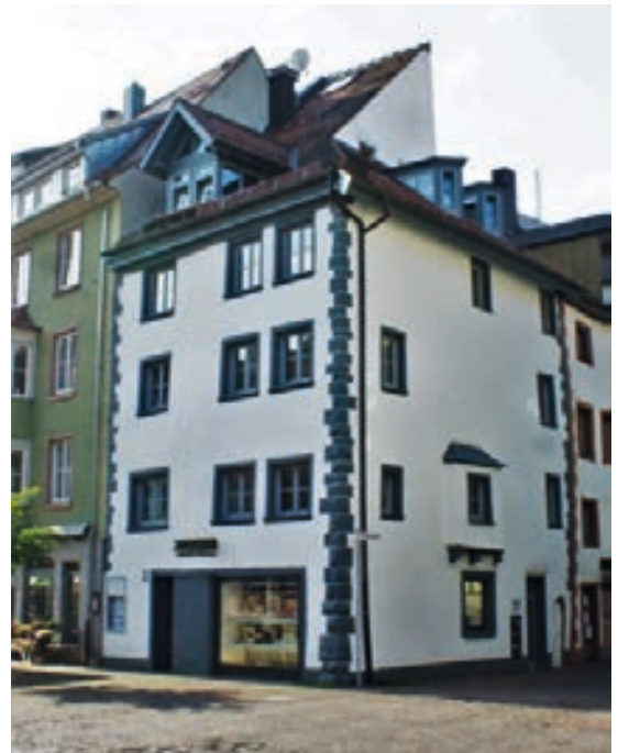
Abb. 18: Villingen, Eckbebauung Rietstraße / Färberstraße.
