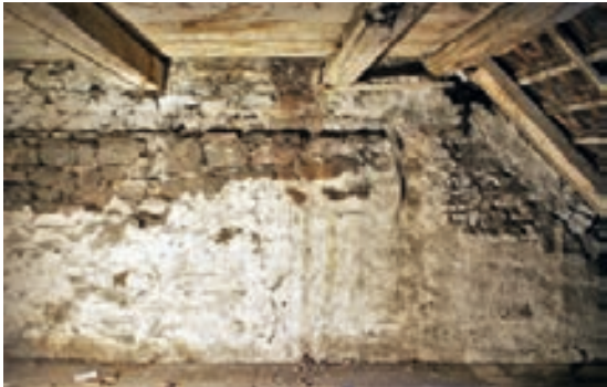
Abb. 26: Villingen, Niedere Straße 38, Blick auf den Südgiebel mit den Negativabdrücken der ehemals auf der Höhe des 1. Dachgeschosses eingemauerten Dachhölzer des Vorgängerdaches.
