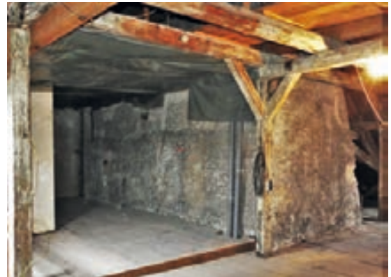
Abb. 22: Villingen, Niedere Straße 37, 2. DG. Blick auf die Pultdachrückwand.
