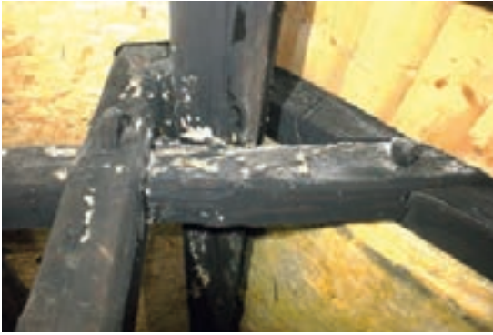
Abb. 17: Villingen, Obere Straße 25. Detail der Auflagerung des Rofenunterzuges 1312(d).
