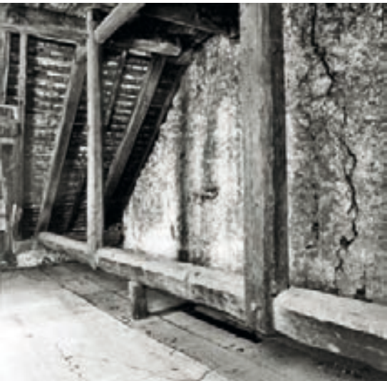
Abb. 40: Villingen, Brunnenstraße 32, Ursprünglich freigespannter und aufgehängter Binderbalken 1351(d).
