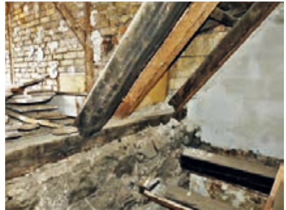
Abb. 36: Villingen, Rietgasse 22, Längsgebundenes Sparrendach. Detail der auf einem niedrigen DrempeI lagernden Sparrenschwelle mit aufgesetztem Sparrenfuß 1507/08(d).
