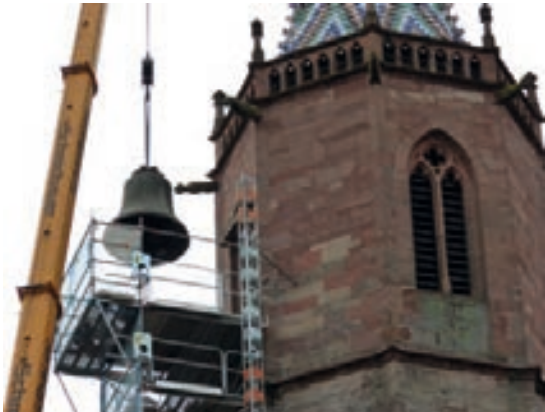
Abb. 25: Am 17. August 2020 wurde die durch einen Sprung beschädigte große Christusglocke aus dem Münsterturm geholt. (Foto: Schultheiß).
