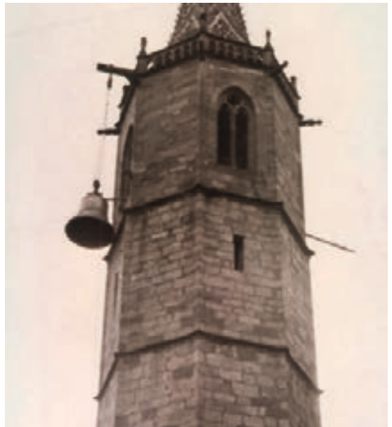
Abb. 22: Die 5400 Kilogramm schwere Christusglocke wird auf den Turm gezogen. (Foto: Archiv Münsterpfarrei).
