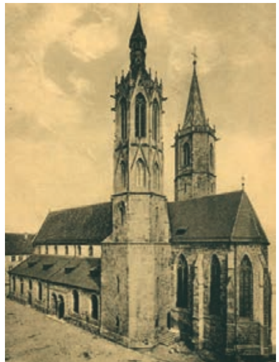
Abb. 2: Das Münster nach 1909 und somit nach Abschluss der Renovierungs- und Umbauarbeiten. (Foto: Archiv Schultheiß).
