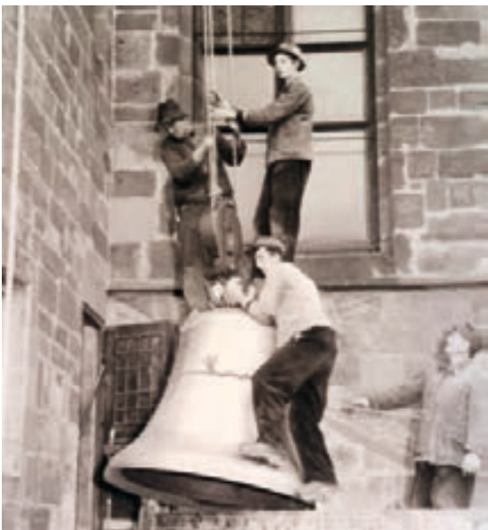
Abb. 20: Die 2065 Kilogramm schwere Marienglocke kommt auf den Turm. (Foto: Archiv Münsterpfarrei).
