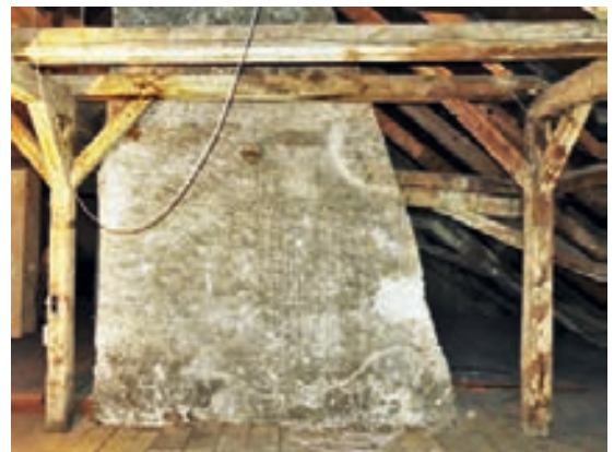
Abb. 23: Villingen, Niedere Straße 37, 2. DG. Blick auf den zur Straße teilweise abgebrochenen Pultdachgiebel im Süden.
