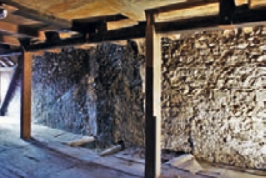
Abb. 28: Villingen, Zinsergasse 16, 1. Dachgeschoss, Blick auf den Südgiebel. Links der Ortgang des Hauses Nr. 18, rechts die Putzkante des Vorgängerdaches von Haus Nr. 16.
