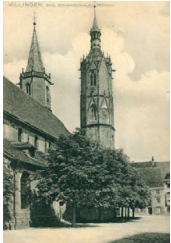
Abb. 1: Das Münster vor der großen Renovierung von 1905 bis 1909. Die Obergeschosse des Südturms (rechts) haben nur relativ kleine Öffnungen und noch nicht die großen neugotischen Schallfenster. (Foto: Archiv Schultheiß).
