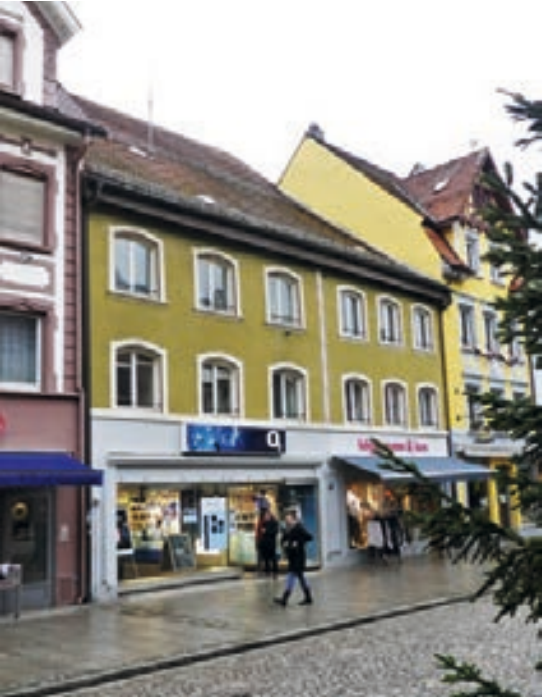
Abb. 19: Villingen, Ansicht Niedere Straße 37.
