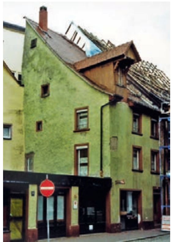
Abb. 31: Im Vordergrund das Pultdachgebäude Gerberstraße 14. Dahinter Gerberstraße 12. Ansicht von Südost.
