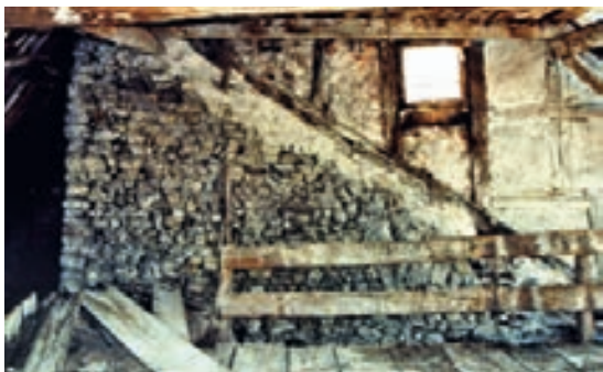
Abb. 32: Villingen, Gerberstraße 12, Ansicht des ehemaligen Pultdachprofils im Süden.
