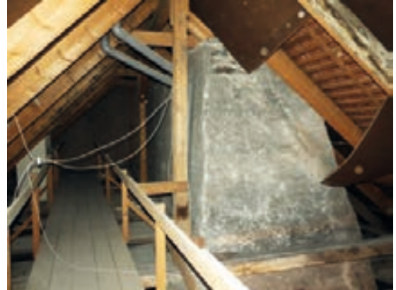
Abb. 21: Villingen, Niedere Straße 37, 3. DG. Unterhalb des heutigen Dachfirstes die horizontale Abbruchkante der Pultdachrückwand.
