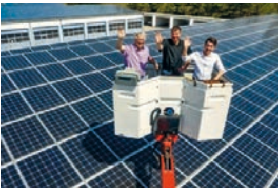
Abb. 1: Photovoltaik auf den Dächern der Stadtwerke. Quelle: Stadtwerke Villingen-Schwenningen.
