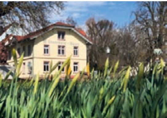
Abb. 2: Ehemaliges Steinbeis-Gebäude in der Gerberstraße.
