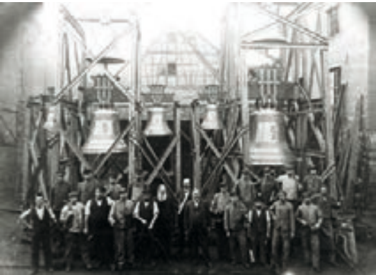
Abb. 3: Das neue Münster geläute im Jahre 1909, aufgehängt an den großen Glockenstühlen aus Stahl, aufgebaut im Hof der Glockengießerei Grüninger in Villingen. (Foto: Stadtarchiv Villingen-Schwenningen).
