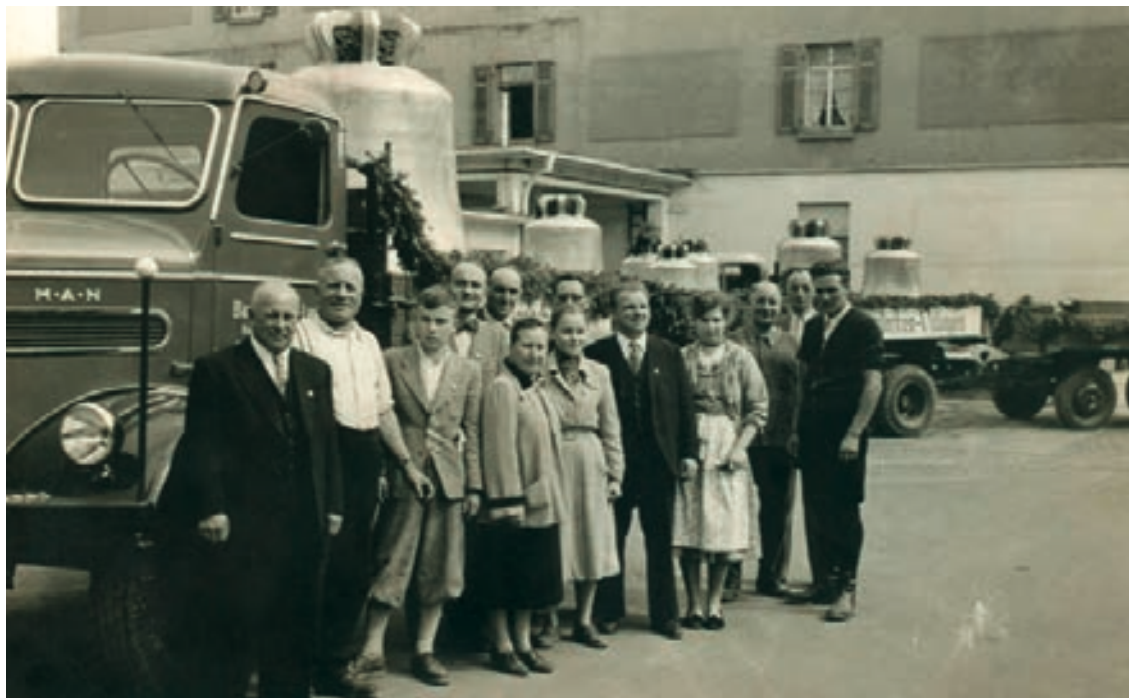
Abb. 11: Auf dem Gelände der Glockengießerei in Heidelberg. Abg. Personen (v.l.n.r.): August Wildi, Christian Huonker, Konrad Baumann, Alfons Bieger, Adolf Ummenhofers., Maria Rohrer, Regina Blaser, Karl Faigle, Helga Kopp, Emil Daiger, Franz Weinmann, Adolf Ummenhofer jun. (Fotos: Nachlass Karl Faigle).
