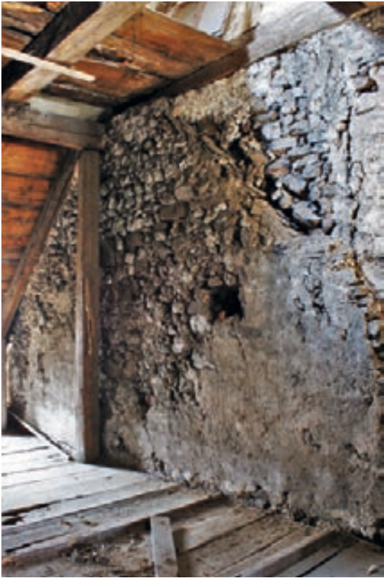
Abb. 8: Villingen, Bickenstraße 5, Blick auf den Giebel zu Haus Nr. 3 mit dessen vorstehendem Giebelndreieck.
