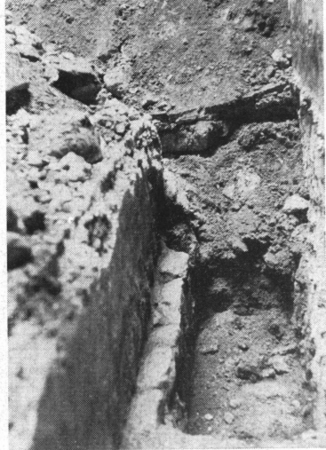
Abb. 6 Turm-Erdgeschoß, Südmauer des älteren Chors mit Fundamentabsatz
