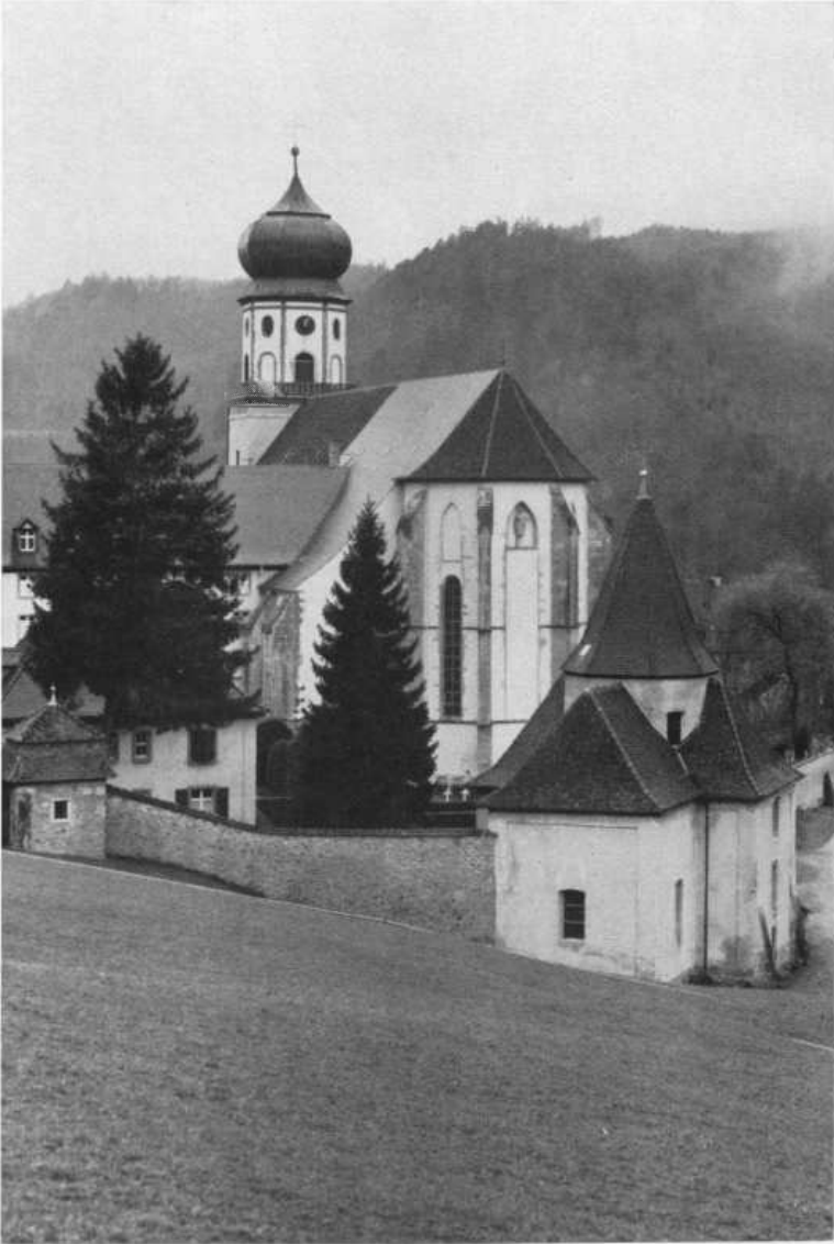
Abb. 10 Ansicht der Klosterkirche mit Teilen des Klosters von Südosten. Im Vordergrund die Trudpertskapelle.
