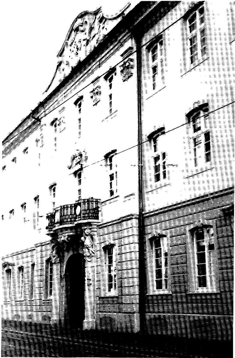
Die wiedererstandene Vorderfront ohne Nebeneingänge und Fensterläden. Photo von H Schmid.
