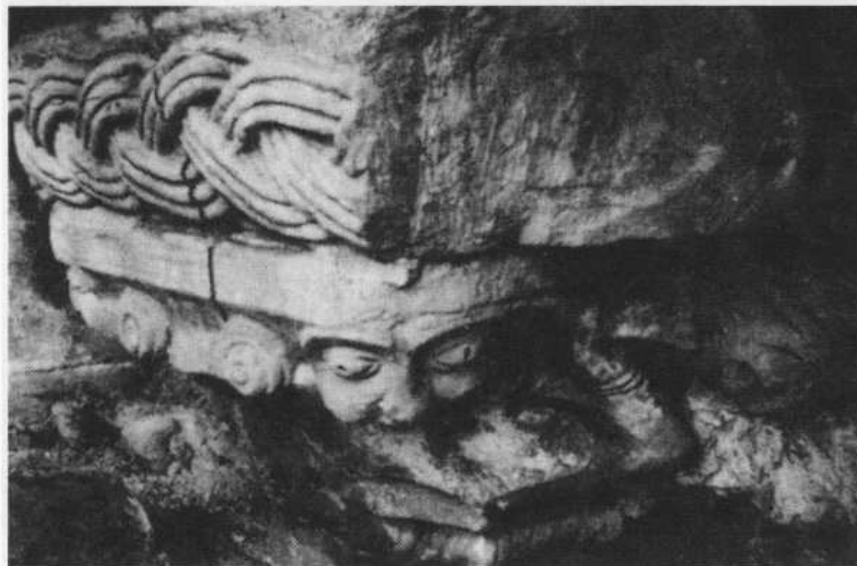
Abb. 31: Nordturm, Nordseite. Doppelfenster des frühen 12. Jhs. Abschluß der Mittelstütze mit Maske und Zopffries. Foto J. Le Brun.
