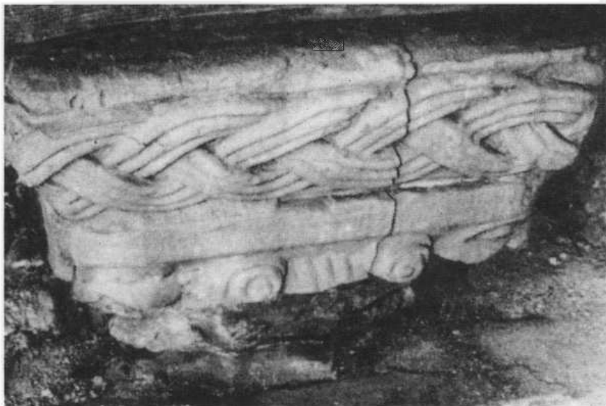
Abb. 30: Nordturm, Nordseite. Doppelfenster des frühen 12. Jhs. (vgl. Abb. 15). Mittelstütze mit Zopffries. Foto J. Le Brun.
