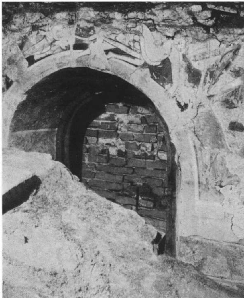
Abb. 29: Rumoldbau 3. V. 11. Jh. Nördliches Seitenschiff. Vermauertes Fenster mit Resten von Malerei (vgl. Abb. 14). Foto J. Le Brun.
