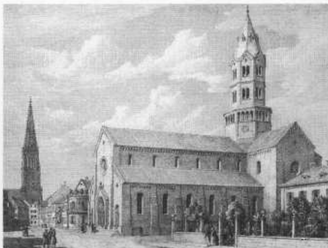
Abb. 13: Lithographie der Ludwigskirche von 1838. Als die Ansicht erschien, war die Ludwigskirche weitgehend fertig. Hübsch wollte wohl die Anpassung seines Turmes an den Freiburger Münsterturm demonstrieren und ließ das Münster dazu abbilden. Tatsächlich steht das Münster viel weiter östlich und ist von diesem Standpunkt aus nicht sichtbar (H. Hübsch, Bau-Werke, Karlsruhe und Baden-Baden 1838, Tafelband).
