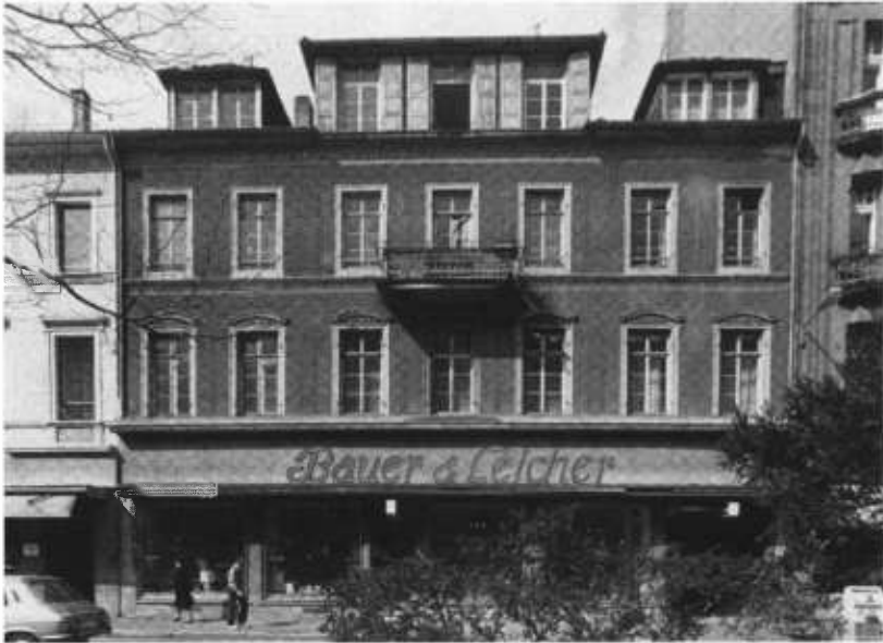
Abb. 15: Das 1874 bezogene Schaffneigebäude in der Leopoldstraße 7 (heute Friedrich-Ebert-Anlage 7). Aufnahme von 1977, Stadtarchiv Heidelberg.
