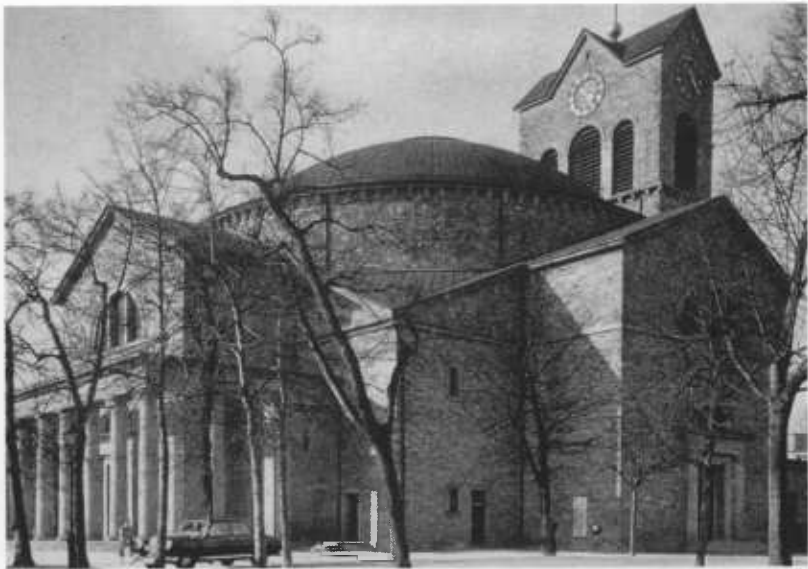
Abb. 18 Stadtpfarrkirche St. Stephan in Karlsruhe, Außenansicht nach dem Wiederaufbau durch Hans Rolli
