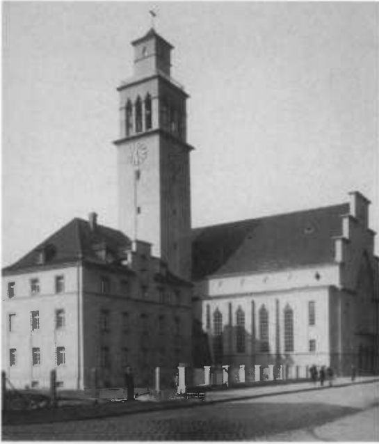
Abb. 9 Pfarrkirche St. Peter in Mannheim, Außenansicht vor der Kriegszerstörung
