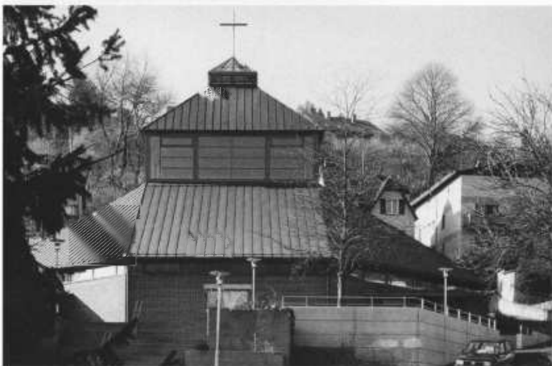
Abb. 32 Pfarrkirche St. Teresa in Heidelberg-Ziegelhausen, Außenansicht
