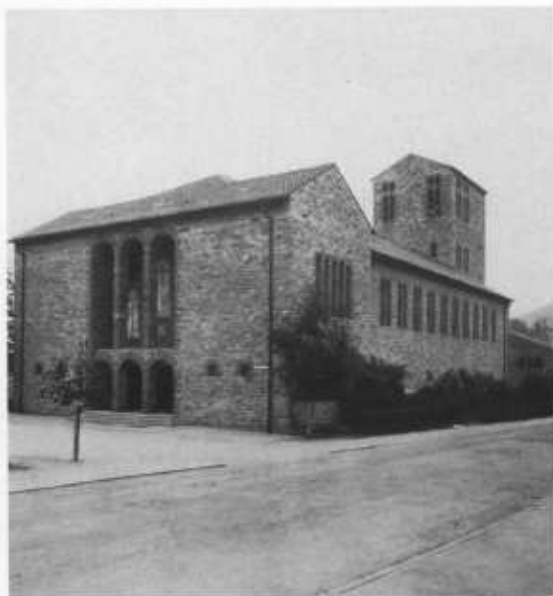
Abb. 14 Pfarrkirche St. Cäcilia in Mosbach, Außenansicht von Westen
