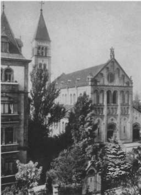
Abb. 6 Pfarrkirche St. Raphael in Heidelberg, Ansicht von Osten
