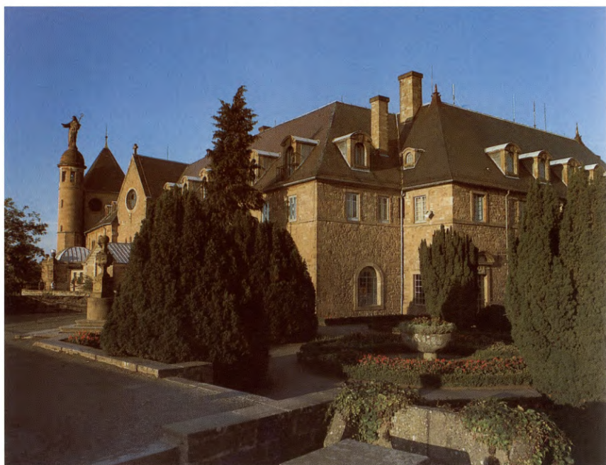
Abb. 5 Gesamtansicht des Klosters
