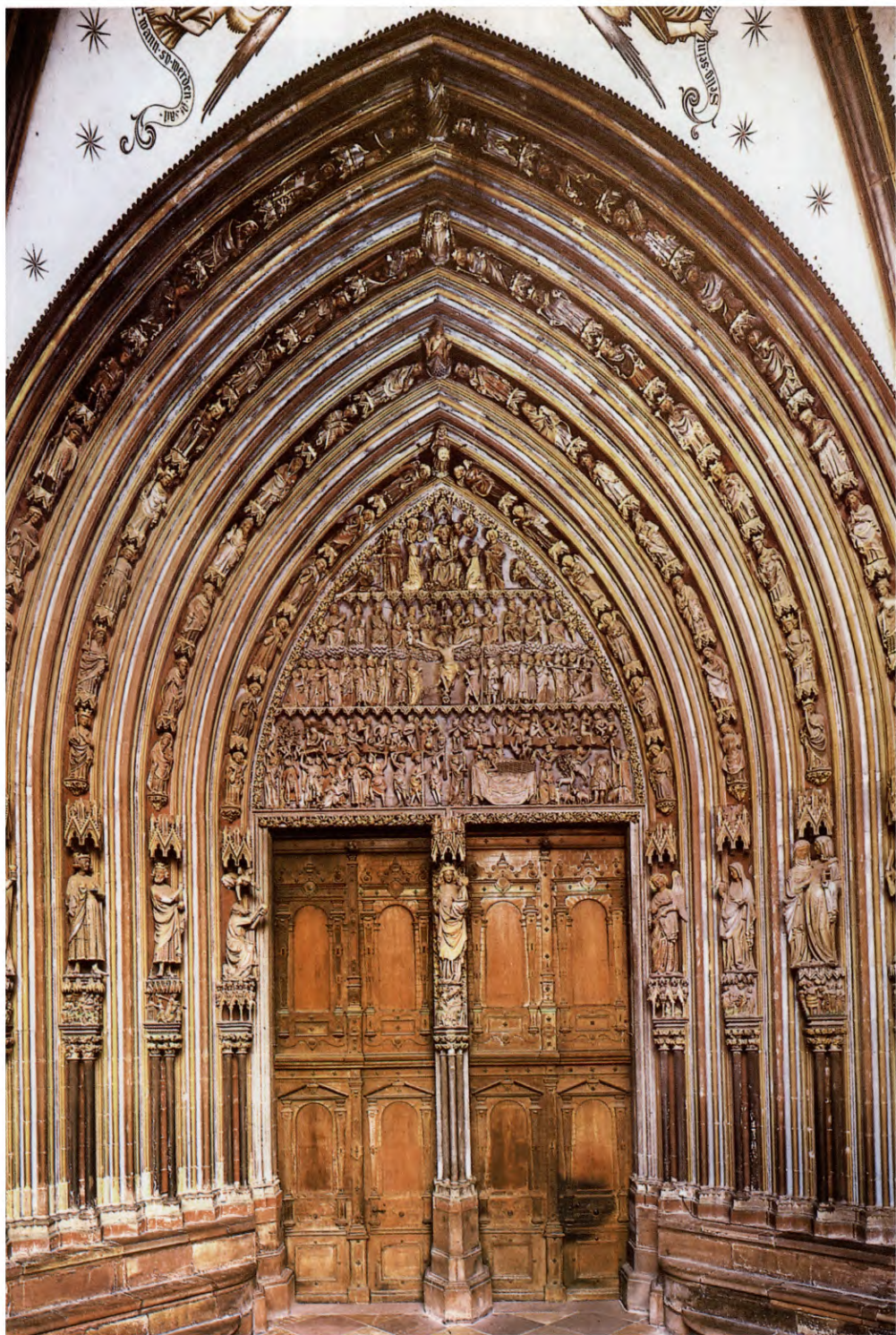
A 1 Westwand des Münsters, hin zur Hauptportalhalle
