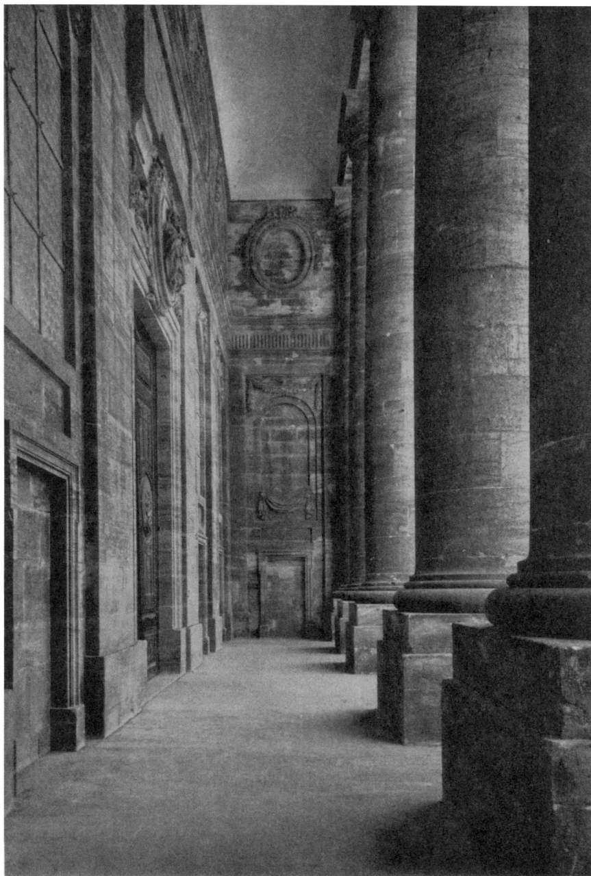
Abb. 6: Säulenvorhalle des Doms von St. Blasien, s. Anm. 329.
