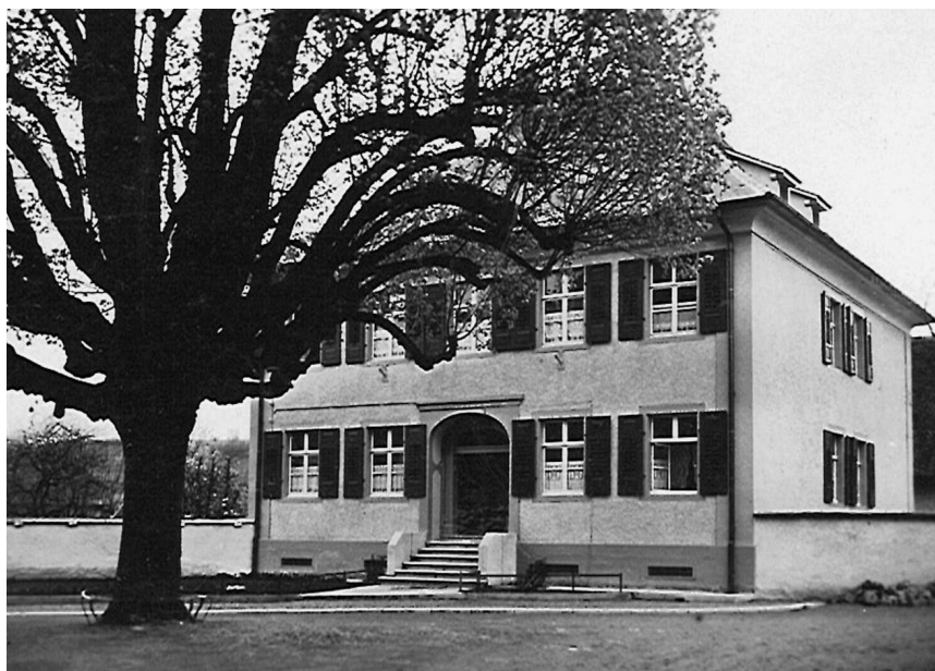
Abb. 1: Pfarrkirche und Pfarrhaus in Wehr.
