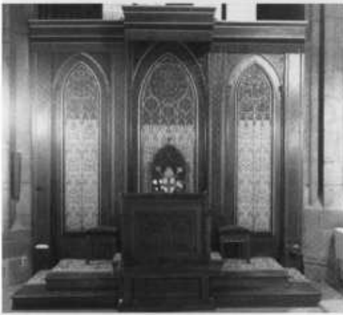
Abb. 20 Der modernisierte (abgewrackte) Bischofsthron wurde in den letzten Jahren noch mehr dezimiert
