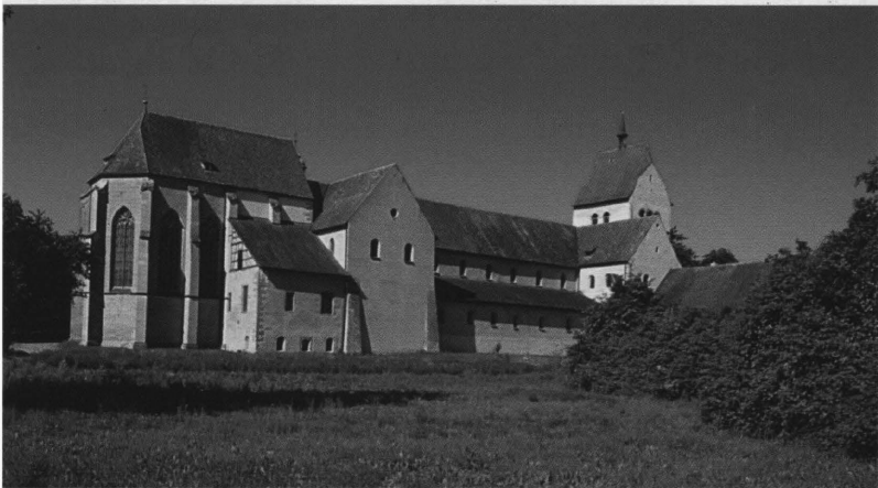
Abb. 2 Das Münster in Mittelzell von Nordosten. Der Chor wurde 1555 vollendet; das östliche Querhaus ist noch jenes von 816, das westliche jenes von 1048
