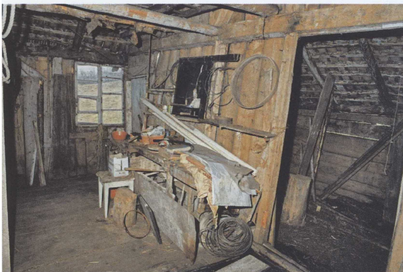
Abb. 12 Blick ins Dachgeschoss des Geburtshauses vor der Renovation. Im Vordergrund die Hobelbank des Vaters Beas
