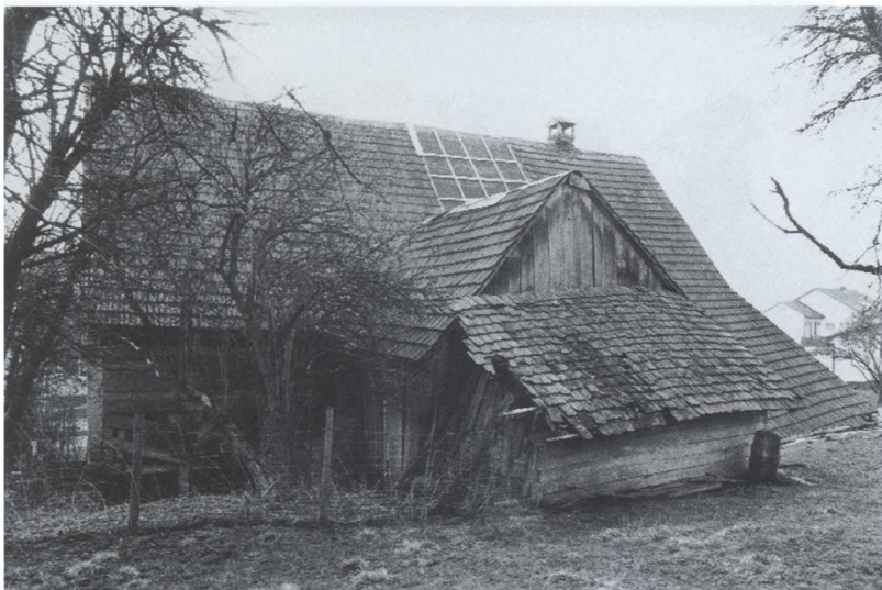
Abb. 11 Das stark verfallene Geburtshaus des Kardinals vor der Renovation (Ansicht von hinten)
