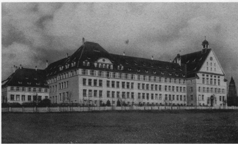
Das Lehrerseminar Rottweil um 1920. Das Glockentürmchen wurde nach der Überführung der Einrichtung in eine nationalpolitische Erziehungsanstalt (NAPO) 1936 samt Glocke abgebaut. Am freigewordenen Platz wurde eine Plattform für Fahnen geschaffen. (Bild: Stadtarchiv Rottweil)
