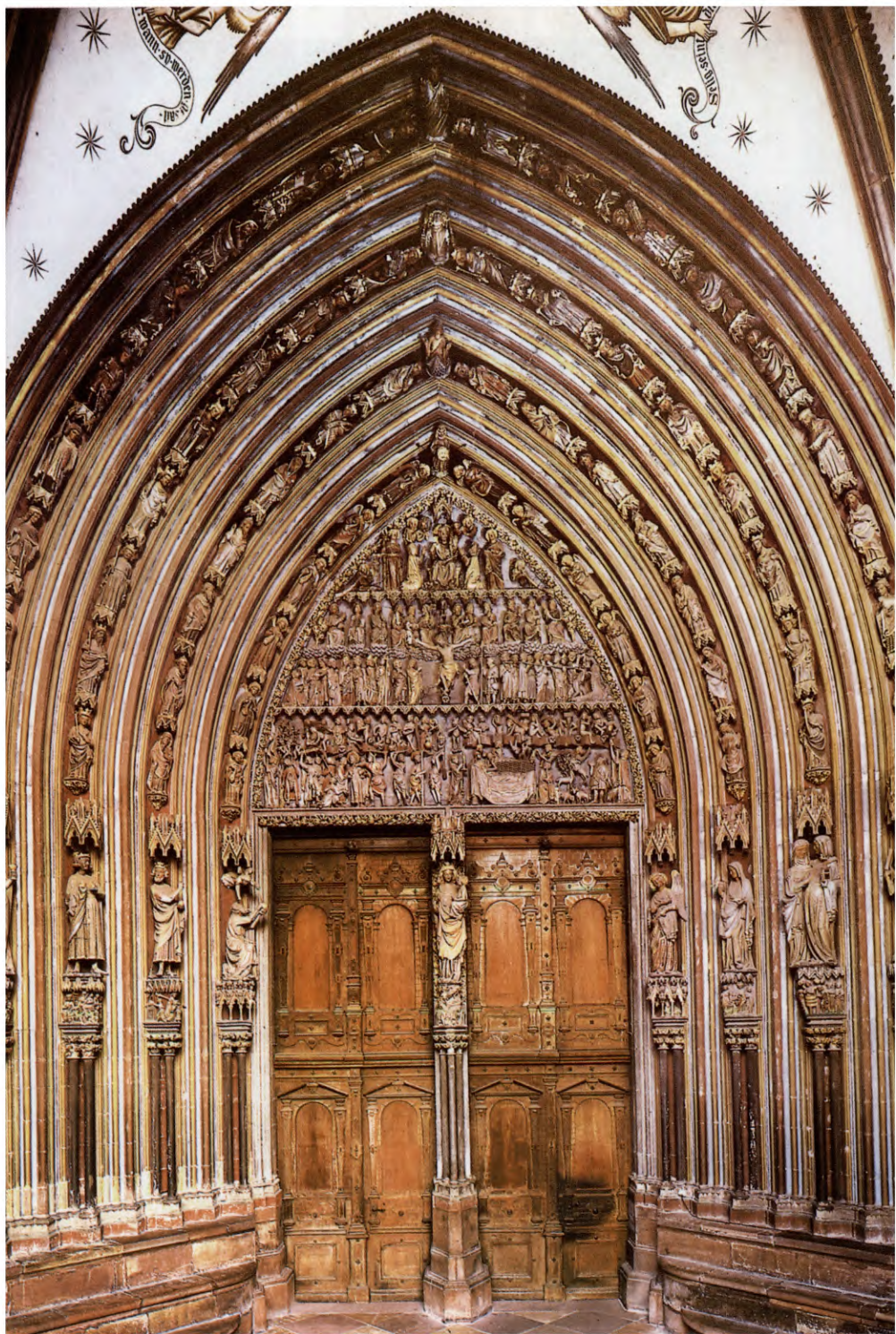
A 1 Westwand des Münsters, hin zur Hauptportalhalle
